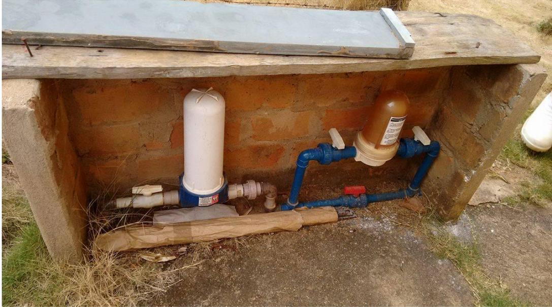
Figura 16: **Filtro e clorador de água.**
