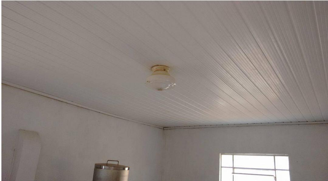
Figura 15: **Lâmpada com proteção.**
