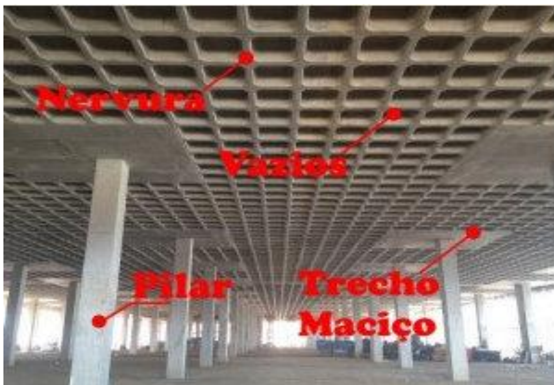
Figura 14 - laje maciça nervurada
