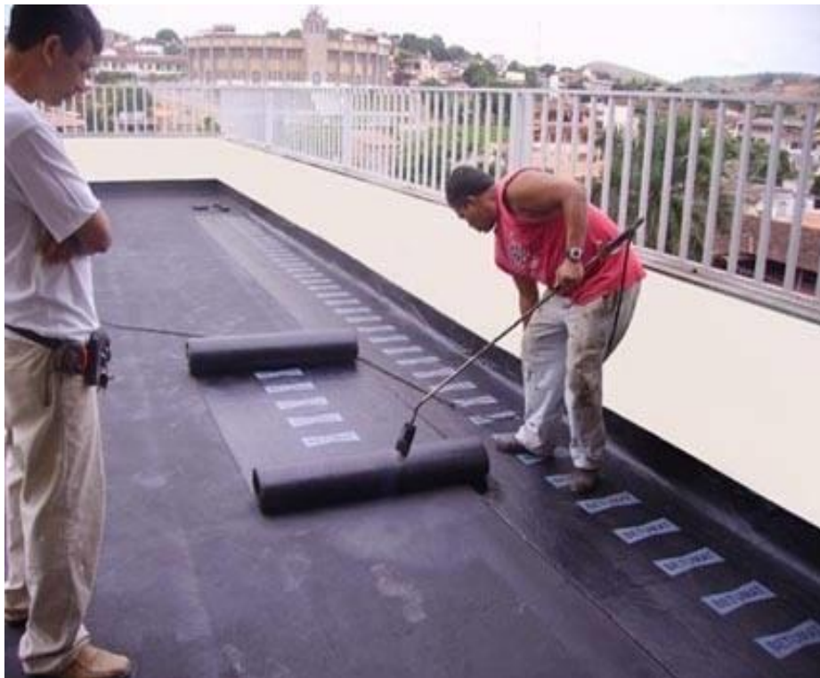
Figura 21 - Execução da manta asfáltica
