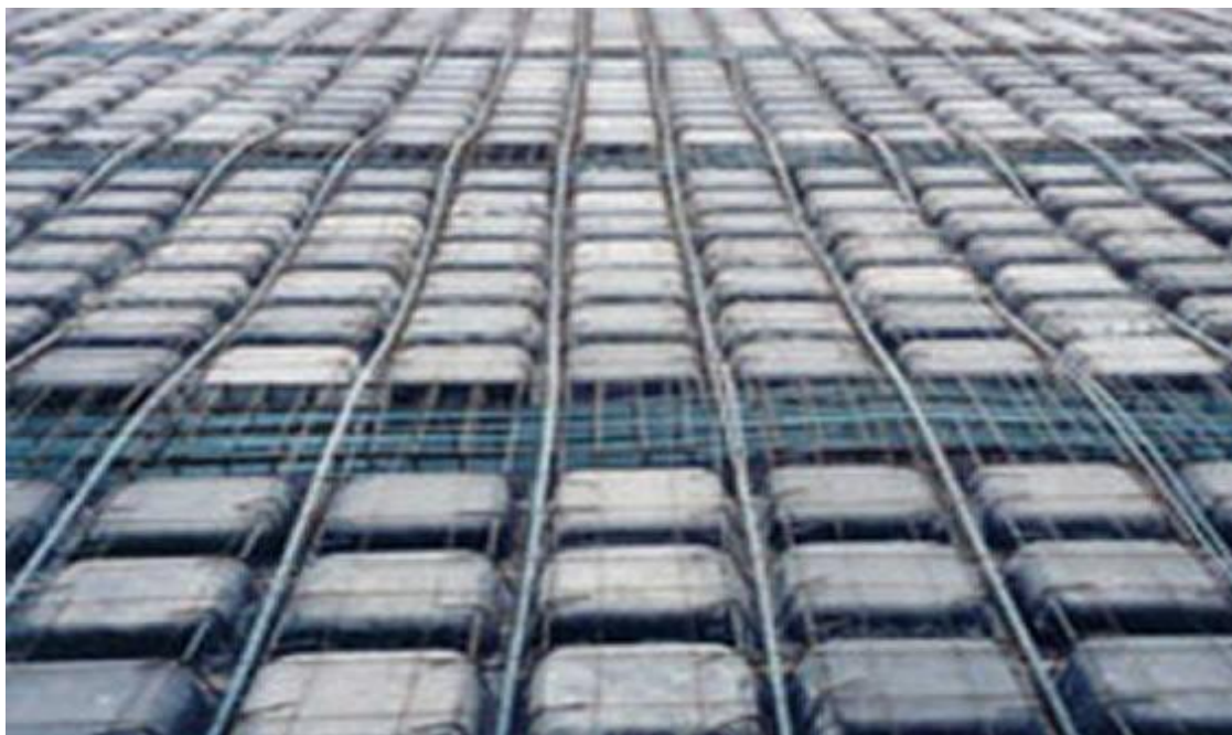
Figura 13 - laje tipo cogumelo
