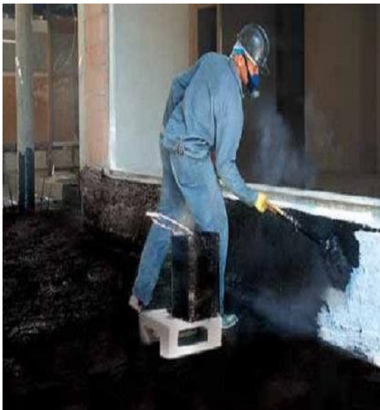
Figura 19 - Execução da membrana de asfalto a quente
