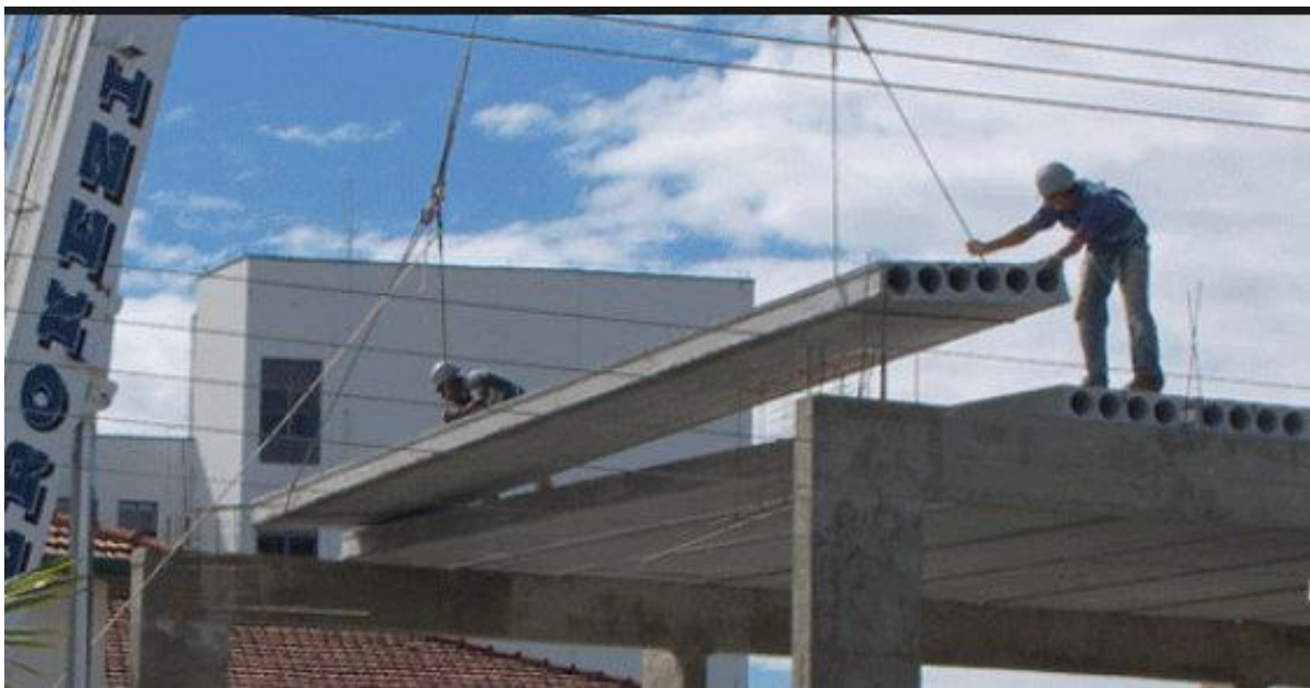
Figura 17 - laje pré-moldada alveolares
