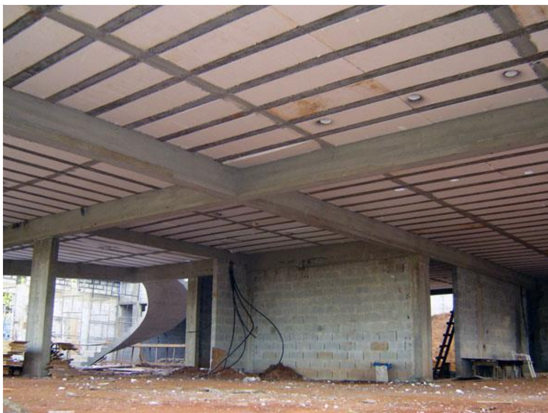
Figura 16 - laje pré-moldada com lajotas de isopor
