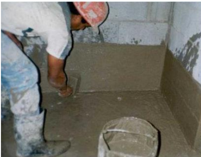
Figura 20 - Execução da membrana acrílica
