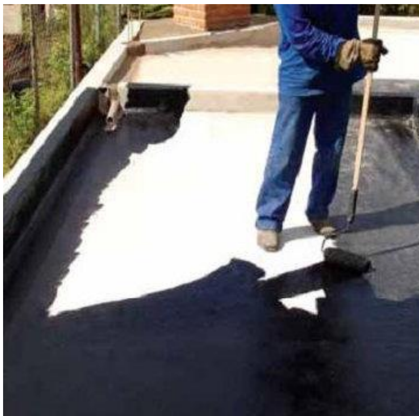
Figura 18 - Execução da membrana de asfalto a frio
