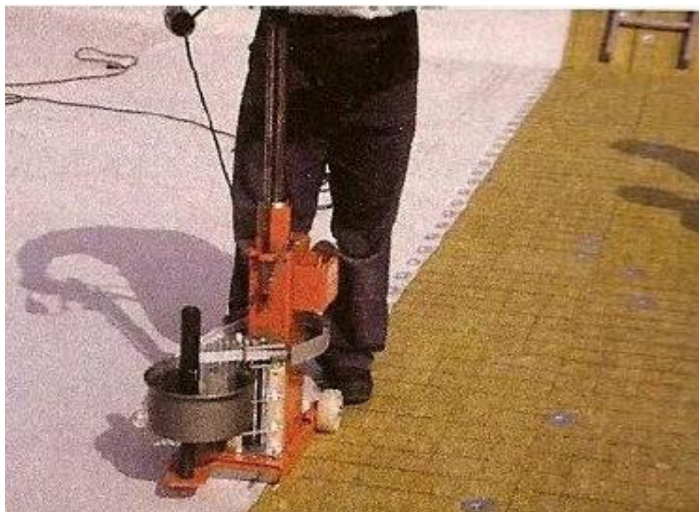
Figura 22 - fixação automática com parafusos e arruelas especiais.
