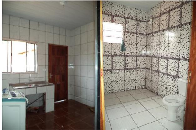
Figura 20 – Revestimento cerâmico das paredes
