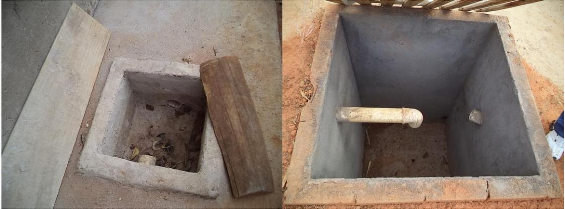
Figura 16 – Caixa de inspeção e fossa séptica
