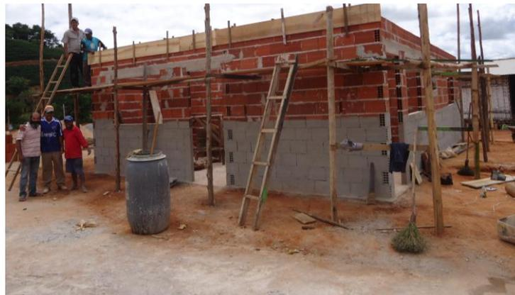
Figura 11 – Execução das vigas de travamento
