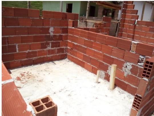
Figura 9 – Lastro de Concreto
