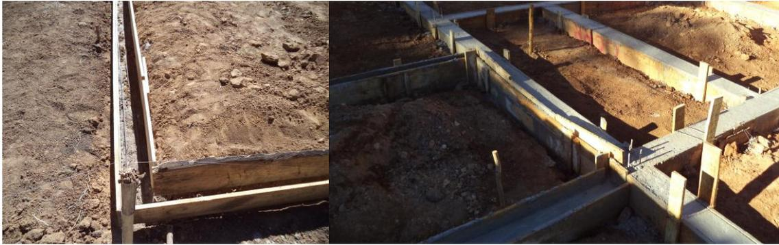
Figura 6 – Montagem das fôrmas e concretagem das vigas baldrame.
