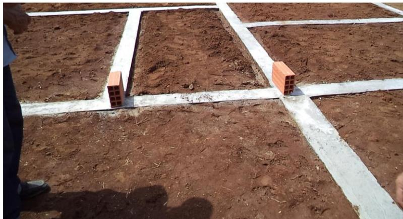
Figura 7 – Vigas baldrame impermeabilizada.
