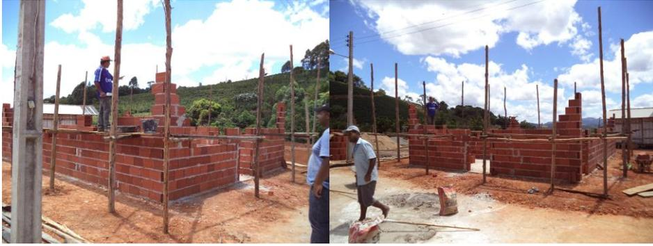
Figura 8 – Confeção da alvenaria.
