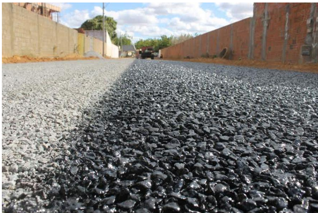
Figura 3 Concreto Asfáltico de Graduação Densa
