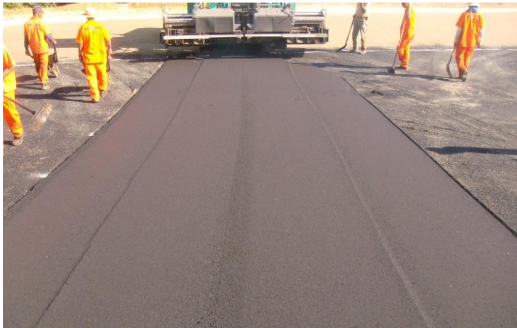
Figura 4 Aplicação de Mistura de Graduação Aberta
