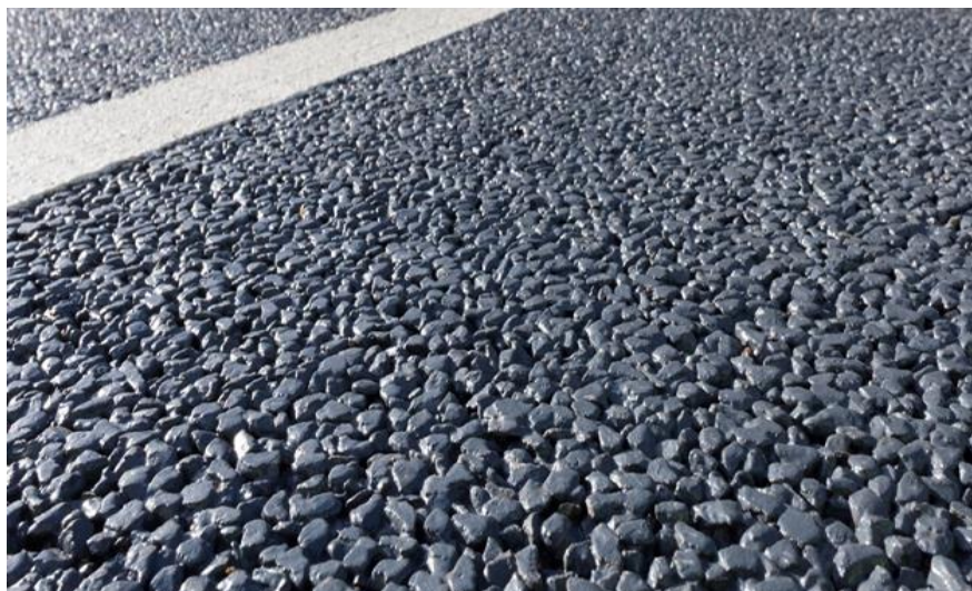
Figura 5 Pavimento Granulação Descontínua
