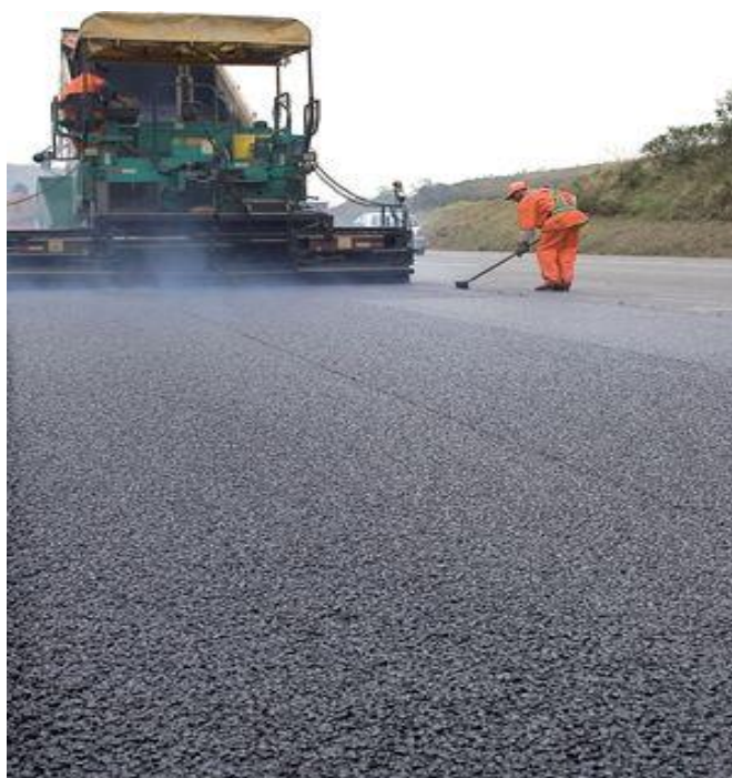
Figura 2 Aplicação de CBUQ
