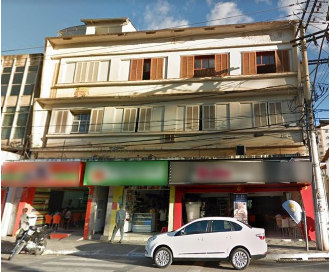
Figura 1-1: Fachada da edificação
