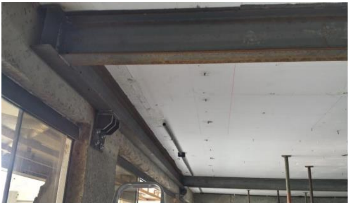
Figura 5-2: Detalhe das vigas durante montagem
