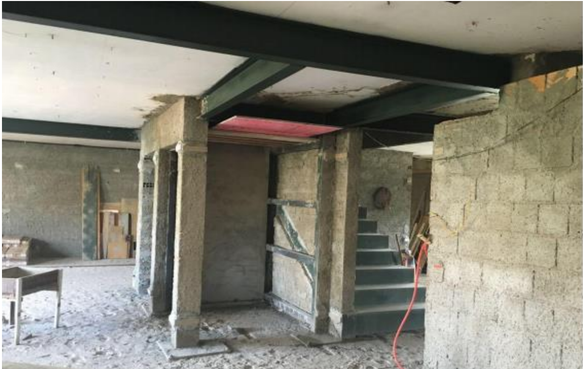
Figura 5-3: Estruturas de vigas interligadas
