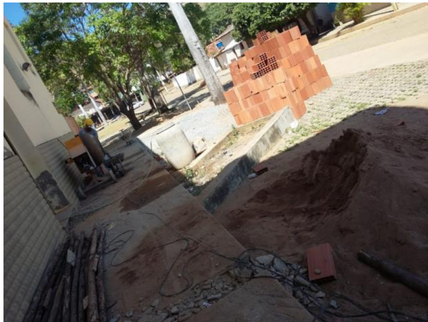
Figura 11: Localização da betoneira
