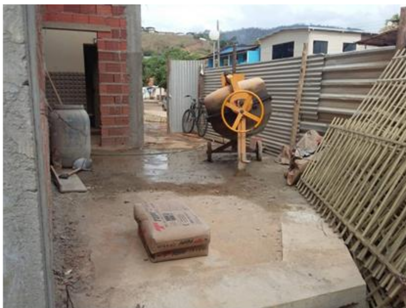
Figura 12: Localização da betoneira feita pela equipe 1
