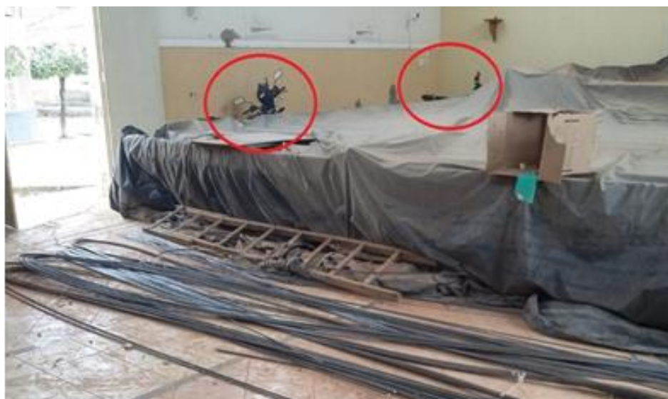
Figura 15: Veículos estacionados dentro da igreja
