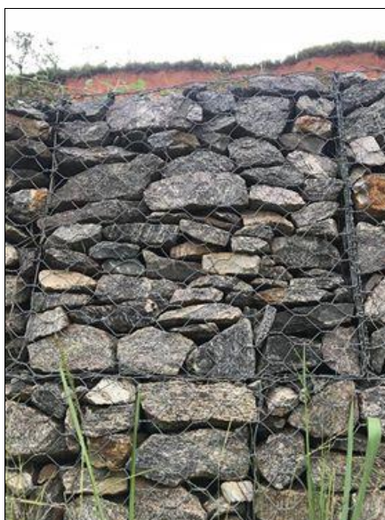
Figura2.12 : Muro de contenção em gabião tipo caixa.
