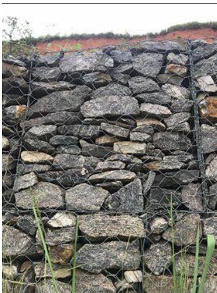
Figura2.13: Preenchimento de gabião.
