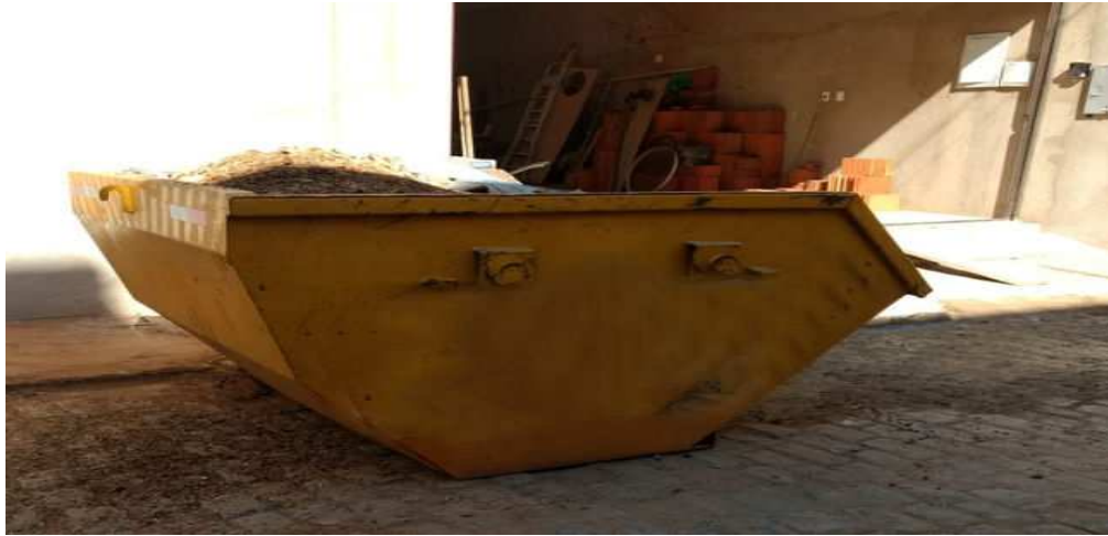
Figura 8: Coleta dos resíduos de construção.
