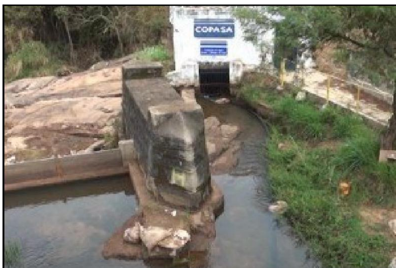
Figura 3: Início da adutora - Caratinga, MG.
