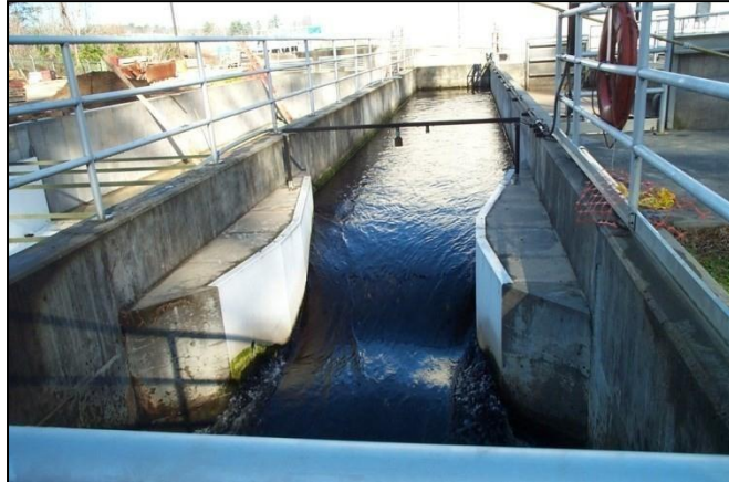
Figura 9: Calha de Parshall
