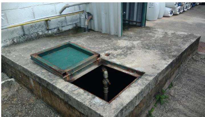
Figura 6 – Reservatório de Água Captada da Chuva
