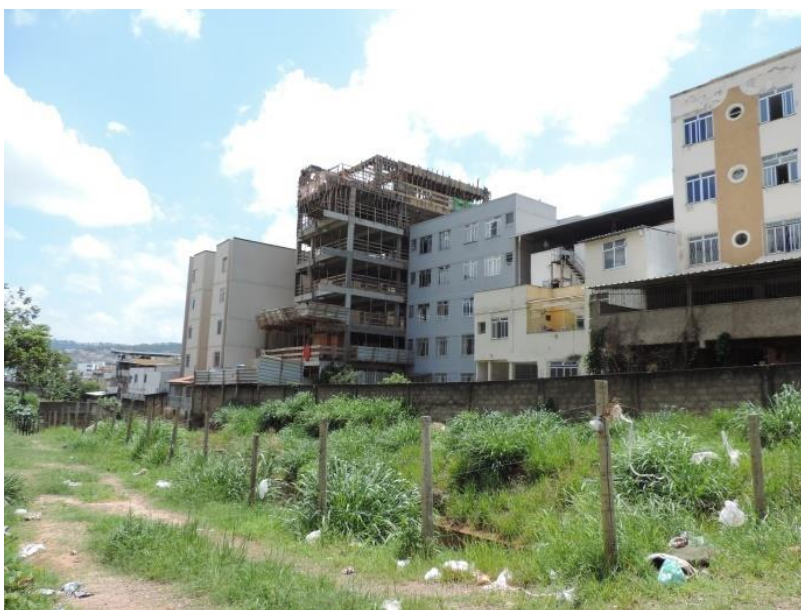
Foto 25. Edificações construídas e nota-se ainda uma em construção, não respeitando a distância definida por lei. Fonte: Arquivo Pessoal. Data: 03 de novembro de 2018.
