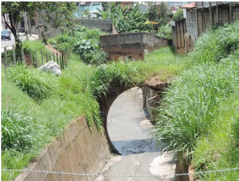
Foto 24. Foto ampliada da canalização feita pela Prefeitura de Juiz de Fora. Fonte: Arquivo Pessoal. Data: 03 de novembro de 2018.
