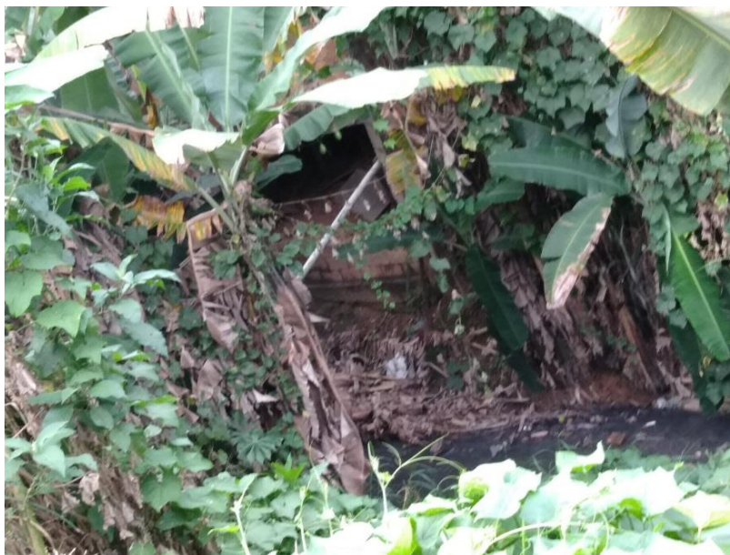
Foto 16. Moradias, taludes e resíduos impróprios. Fonte: Arquivo Pessoal. Data: 03 de novembro de 2018.
