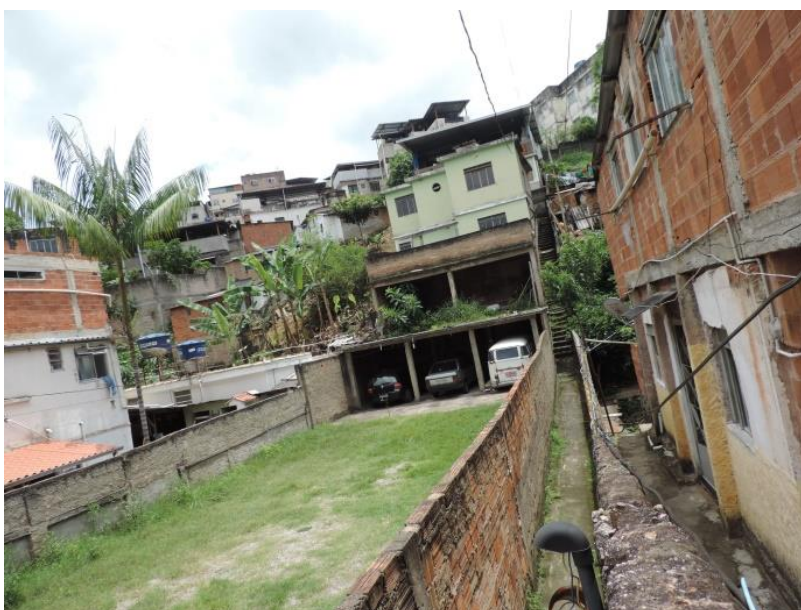
Foto 15. Casa que foi construída acima da fundação. Fonte: Arquivo Pessoal. Data: 03 de novembro de 2018.
