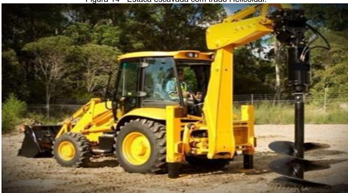
Figura 14 - Estaca escavada com trado Helicoidal.
