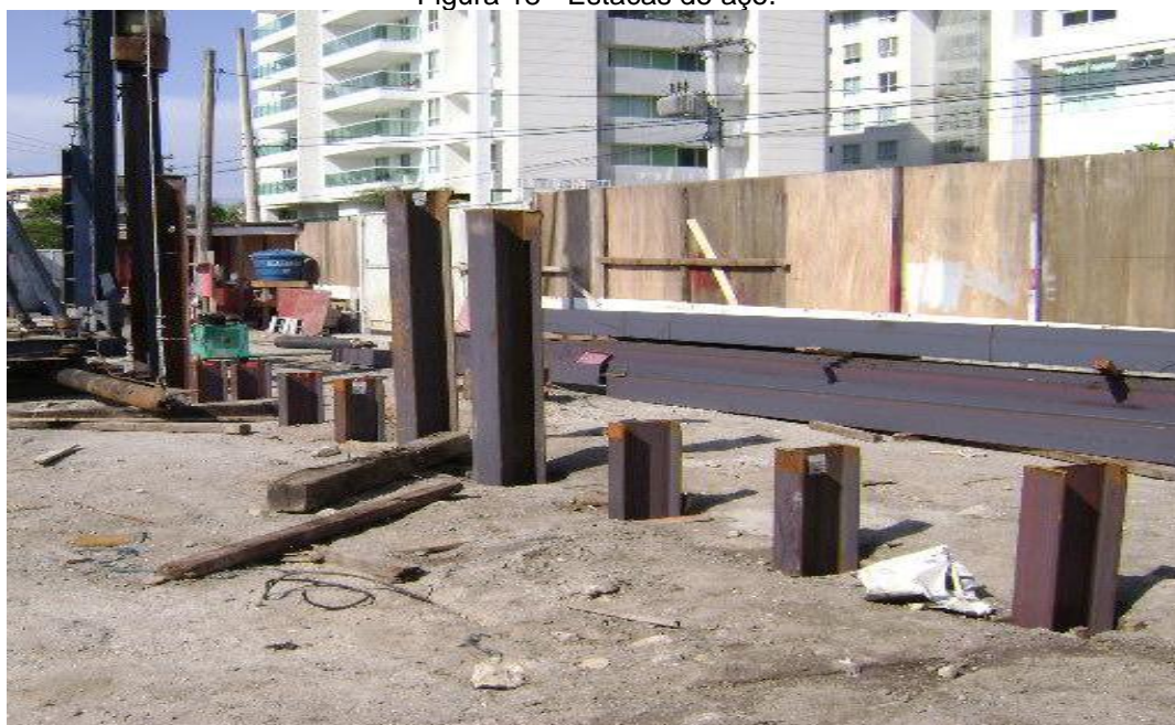
Figura 18 - Estacas de aço.
