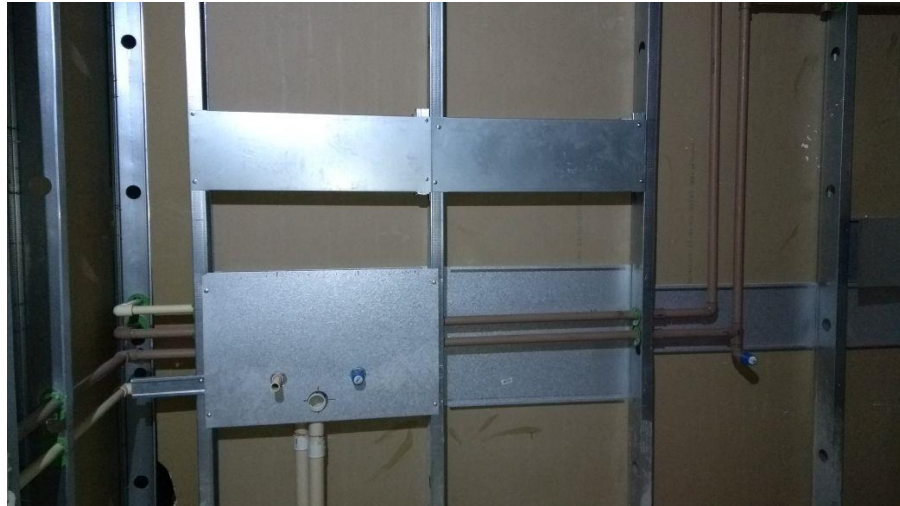
Figura 13 – Representação de instalações hidráulicas em drywall
