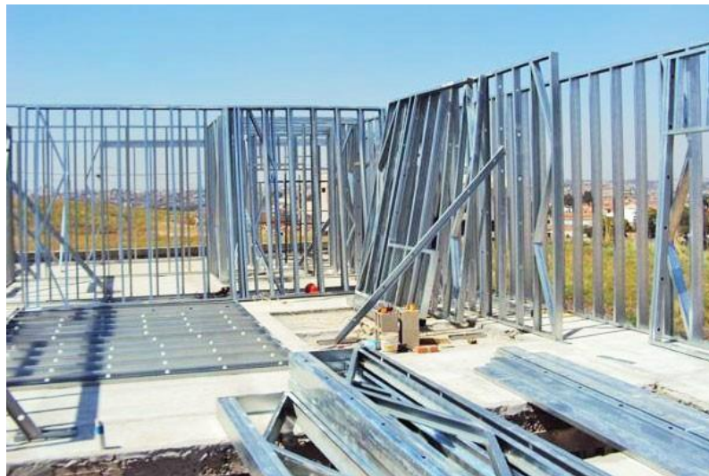
Figura 5 – Método de construção a seco
