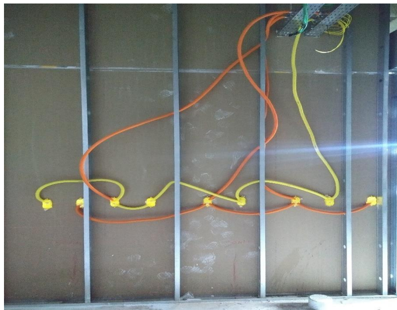
Figura 12 – Representação de instalações elétricas em drywall
