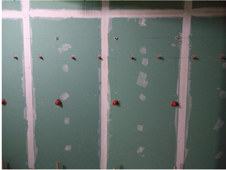
Figura 7 – Representação da chapa resistente à umidade (RU)
