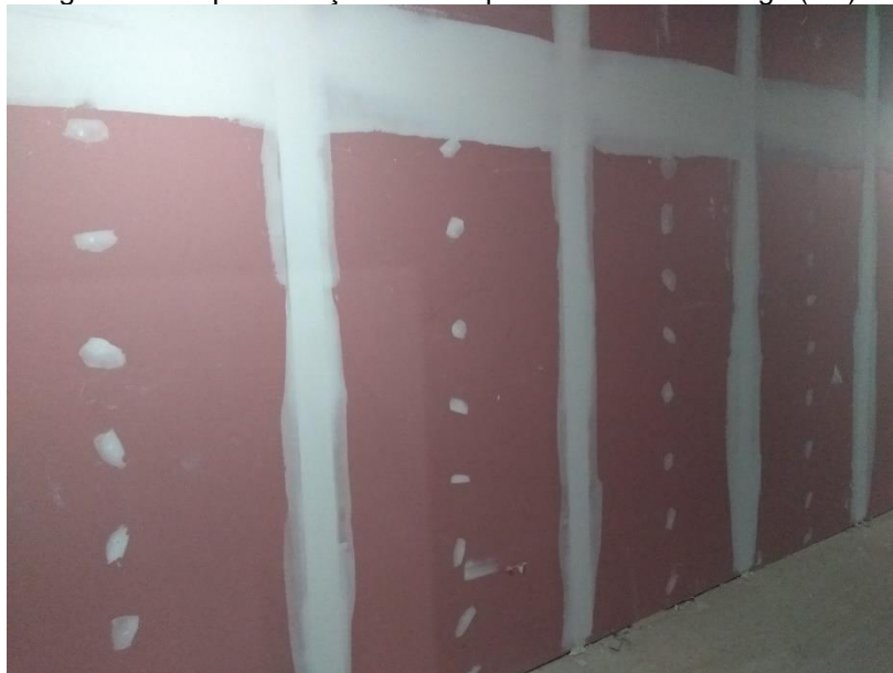
Figura 8 – Representação das chapas resistentes ao fogo (RF)
