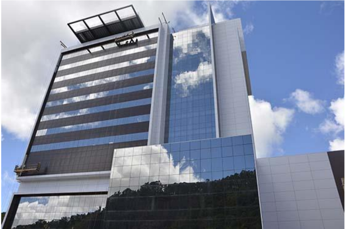
Figura 1 – Imagem frontal do empreendimento
