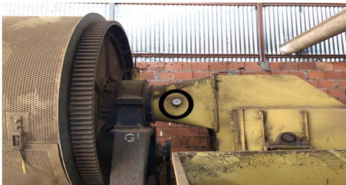
Figura 5: Medidor para parâmetro de temperatura que entra no secador possuindo uma funcionalidade de 0° a 150°C.
