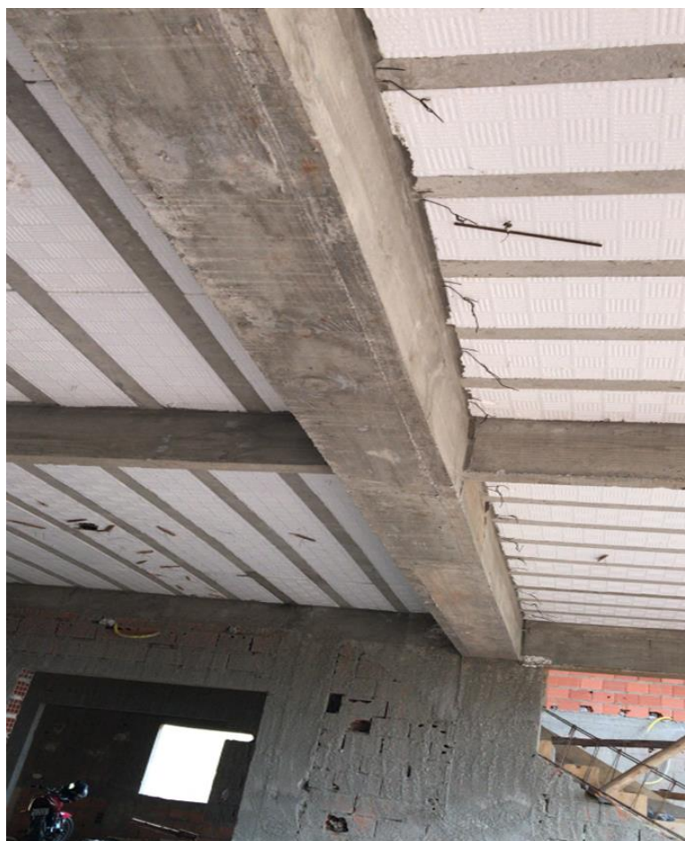
Figura 2.5: Viga de concreto armado.
