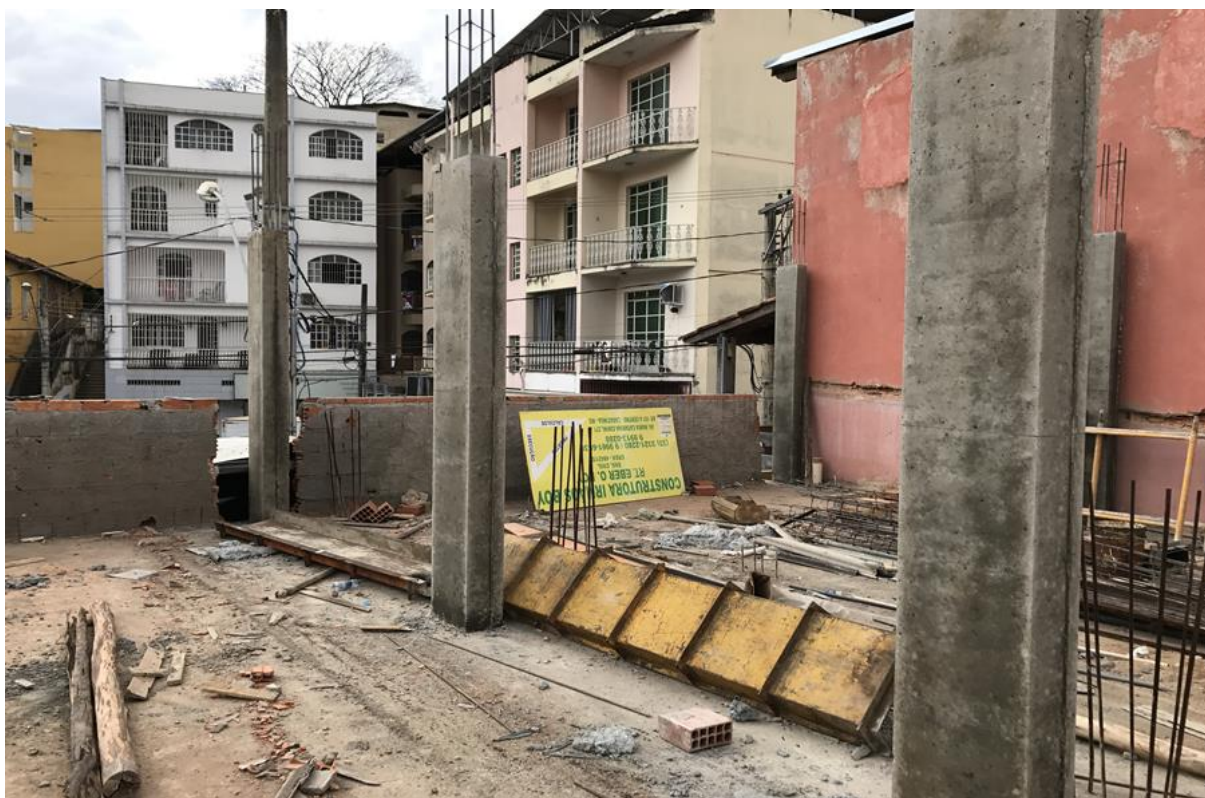
Figura 2.4: Pilares de concreto armado.
