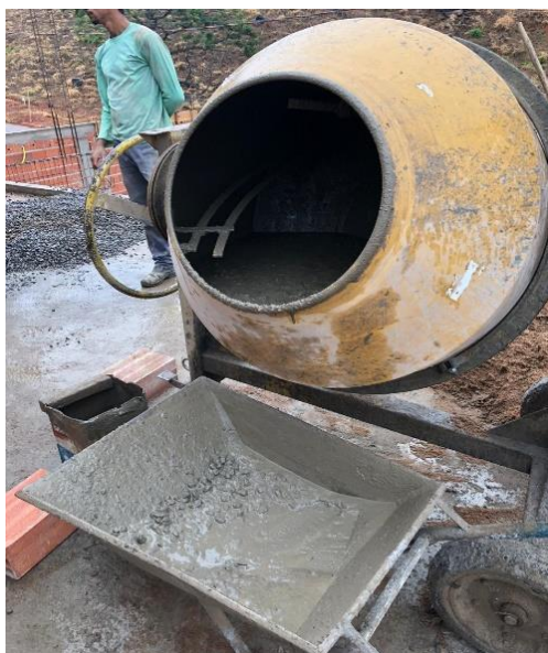
Figura 3.2: Concreto produzido com auxílio de betoneira.
