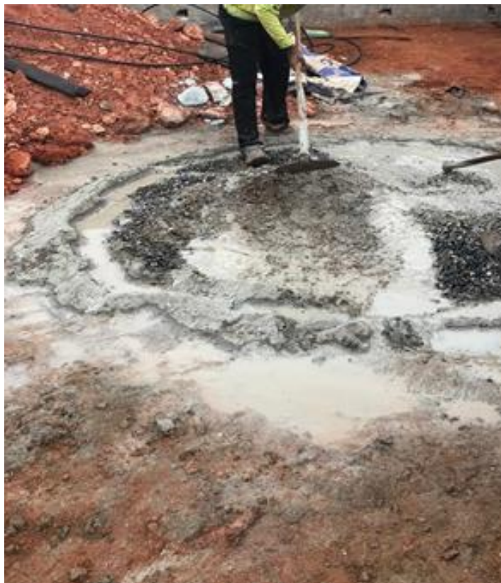
Figura 3.3: Concreto moldado de maneira manual com auxílio de enxada.
