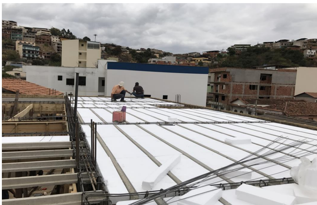
Figura 2.6: Lajes treliçadas com utilização de placas de isopor.
