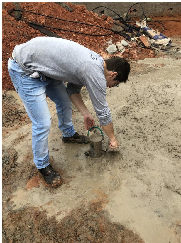
Figura 3.6: Retirada do excesso de concreto com auxílio de colher de pedreiro.
