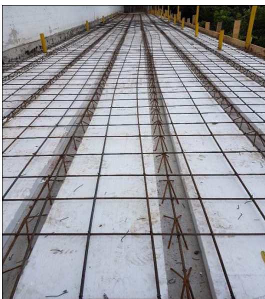
Figura 2.7: Edificação com laje de isopor
