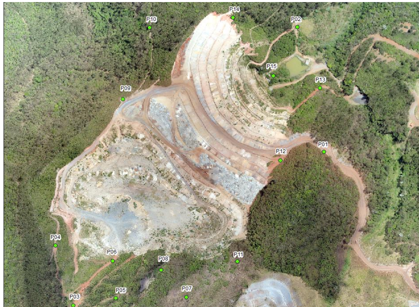
Figura 10 - Mina do Andrade- Mapeamento das pilhas de estéril.
