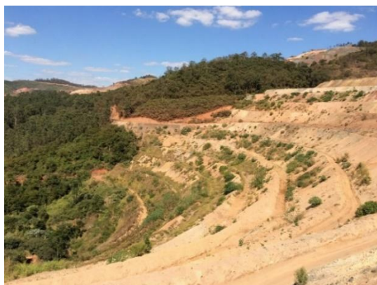
Figura 16 - Bermas iniciais da Pilha.
