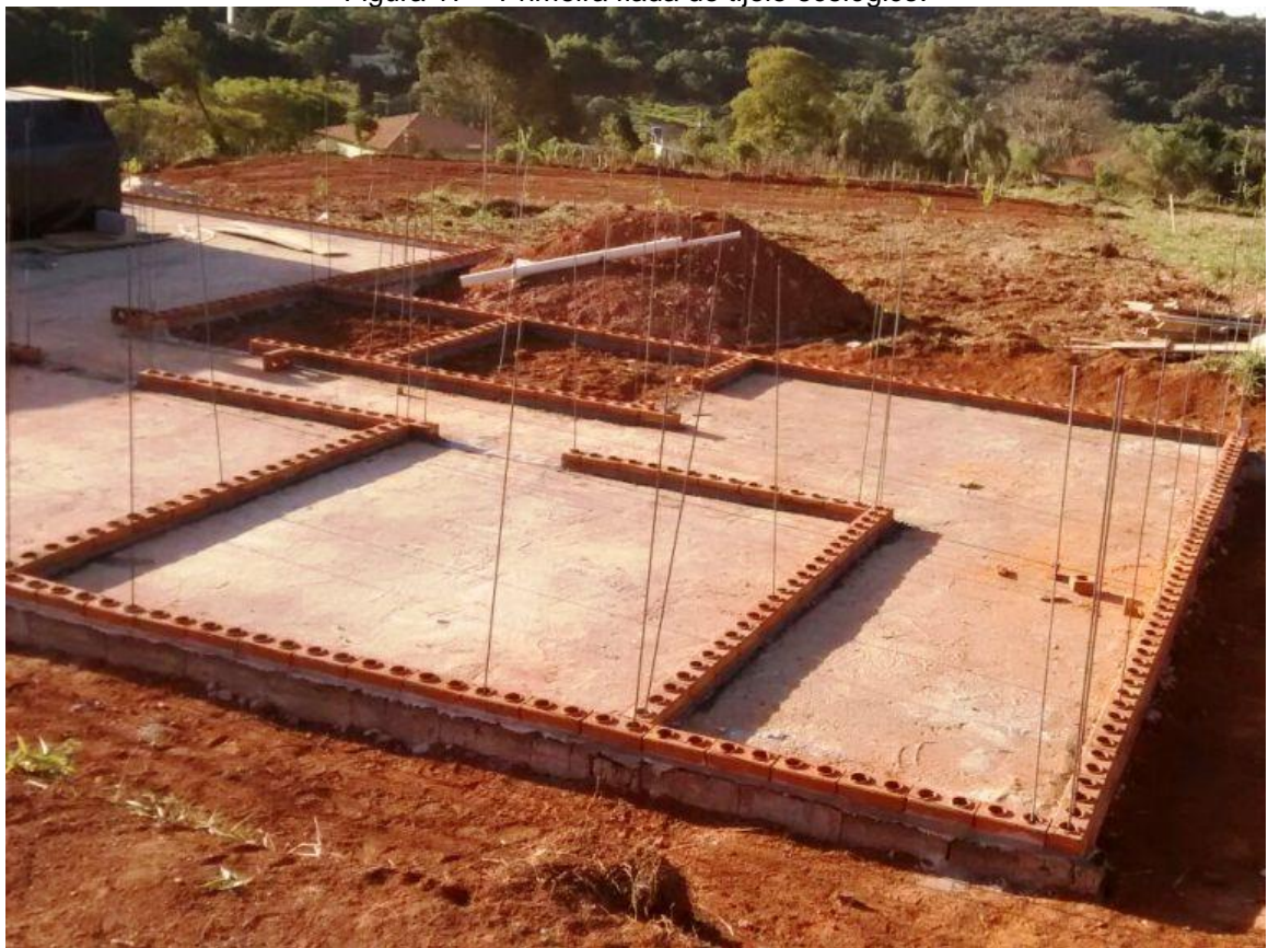
Figura 17 – Primeira fiada do tijolo ecológico.
