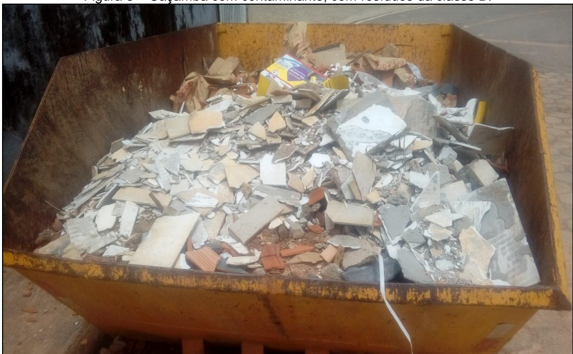
Figura 5 – Caçamba com contaminante, com resíduos da classe B.
