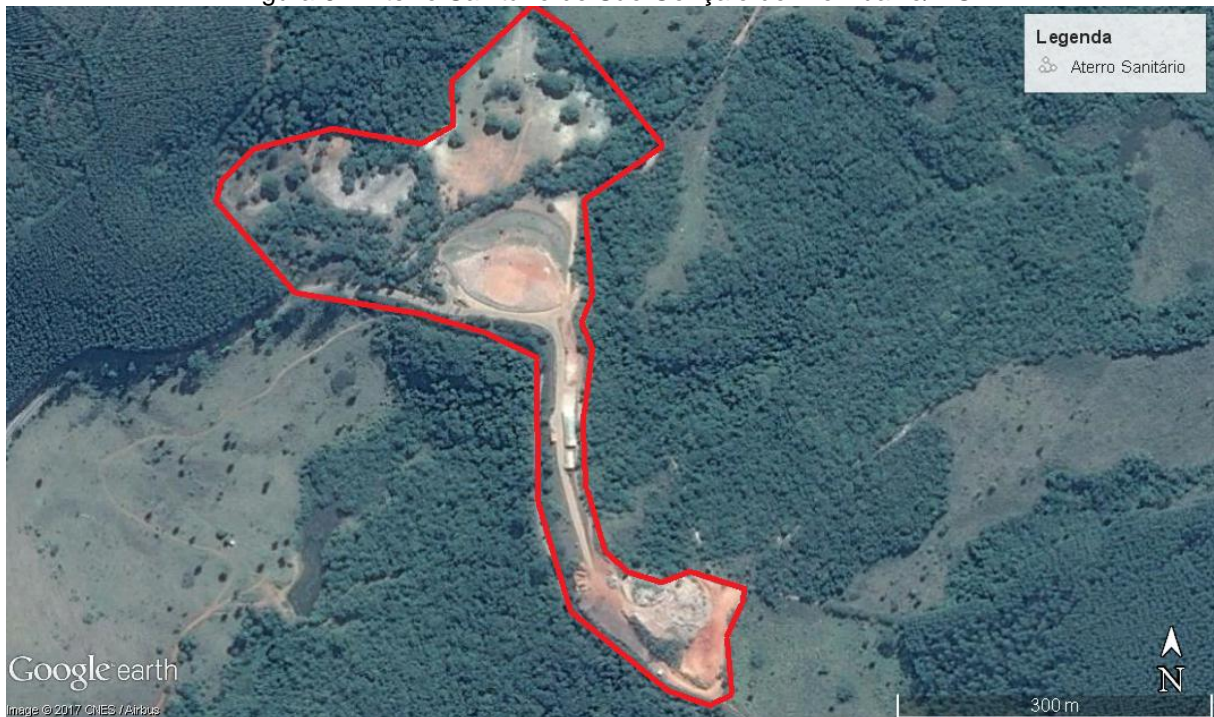
Figura 6 – Aterro Sanitário de São Gonçalo do Rio Abaixo/MG.
