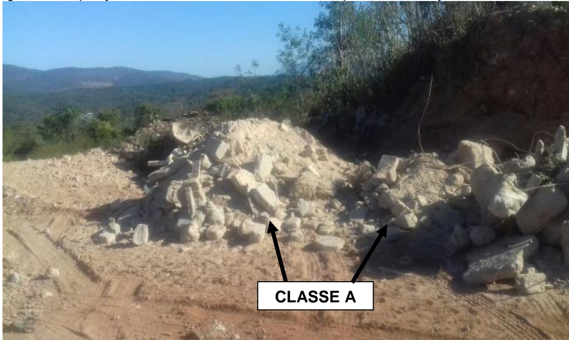
Figura 8 – Disposição de RCCD Classe A no aterro municipal de São Gonçalo do Rio Abaixo/MG.
