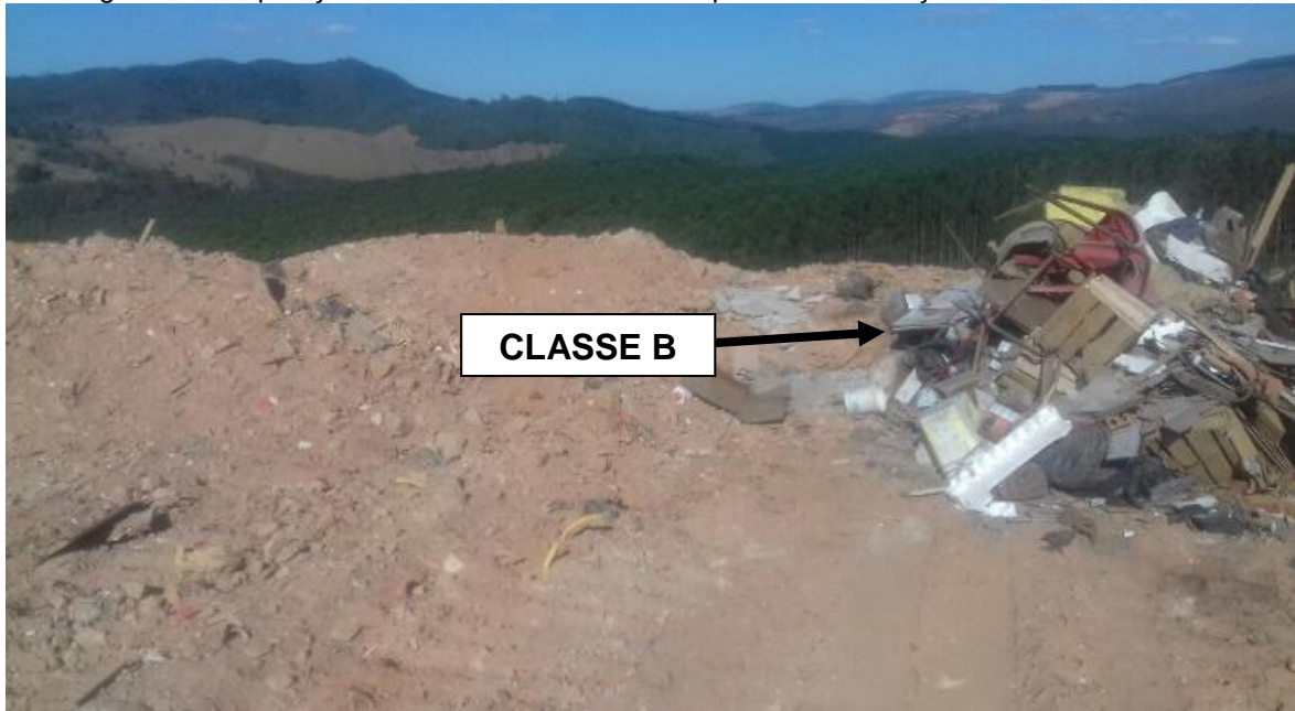
Figura 9 – Disposição de RCCD no aterro municipal de São Gonçalo do Rio Abaixo/MG.
