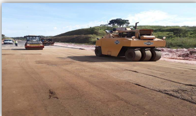
Figura 24- Vista geral da Compactação da Camada
