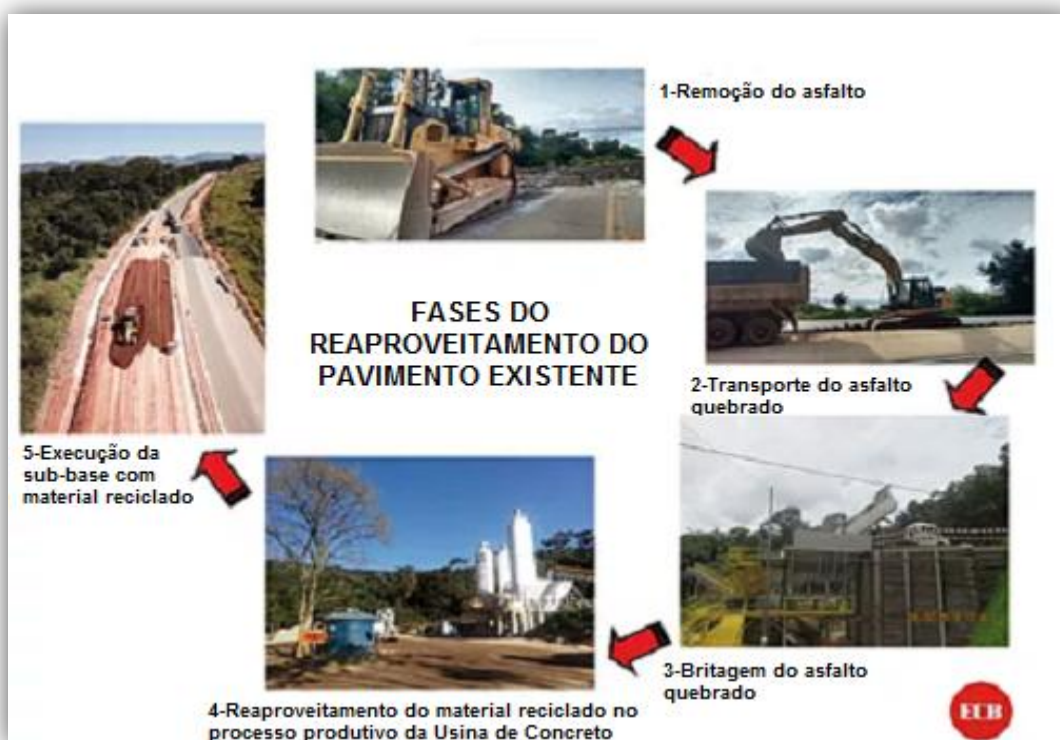
Figura 21- Fases do Reaproveitamento do Pavimento Existente
