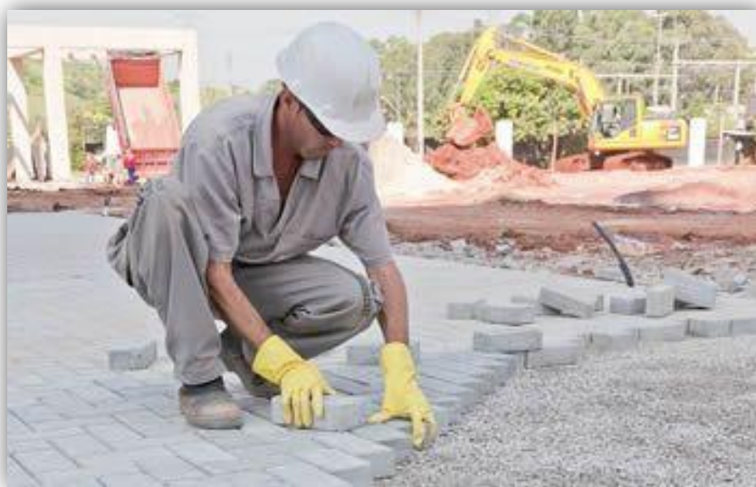
Figura 11- Pavimento Pré Moldado
