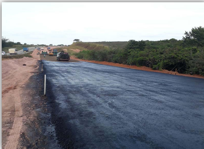
Figura 26- Execução da Pintura contra Evaporação de Água
