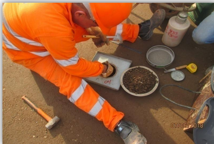
Figura 32- Realização da Escavação com Bandeja de Furo no Centro.
