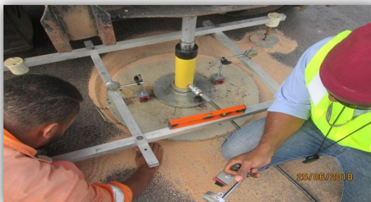
Figura 35 - Montagem dos Equipamentos para Ensaio de Recalque
