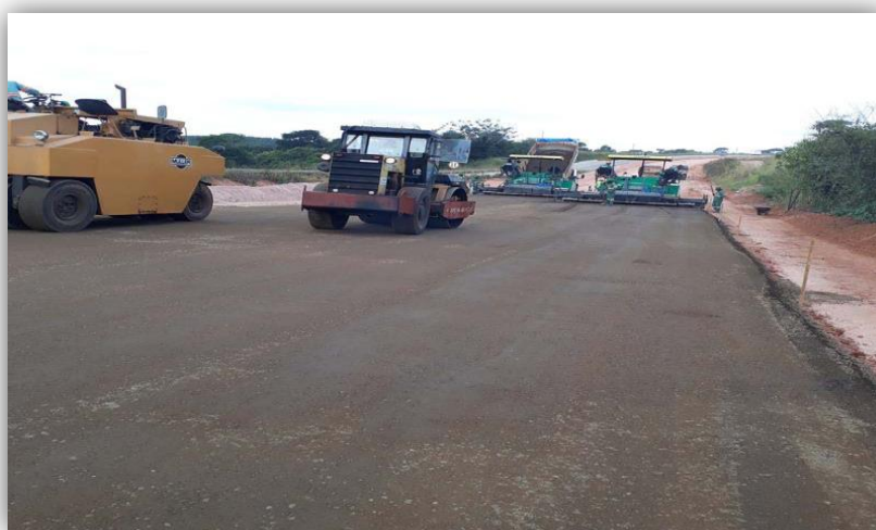
Figura 22- Vista geral da execução da Camada de Reciclados.
