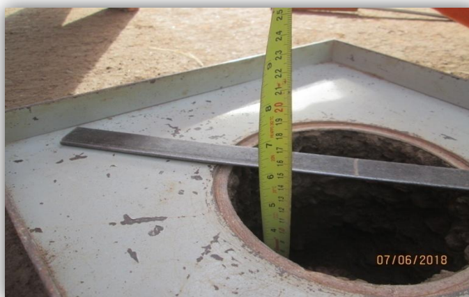
Figura 33- Profundidade da Escavação
