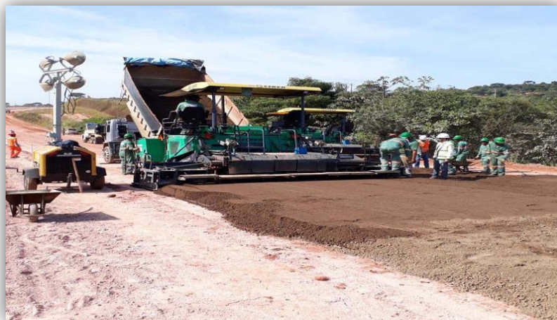
Figura 23- Espalhamento dos Reciclados com Cimento
