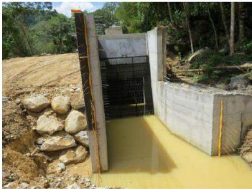
Figura 12: Tomada de Água da CGH Médio Garcia
