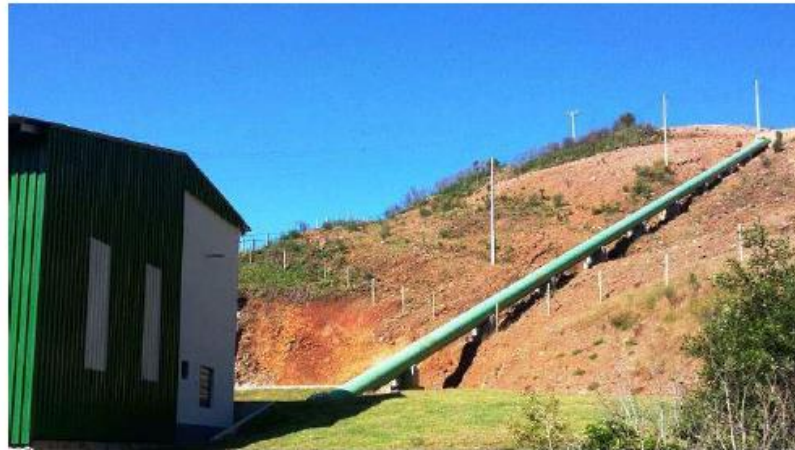
Figura 17: Conduto Forçado da CGH Willy Faller
