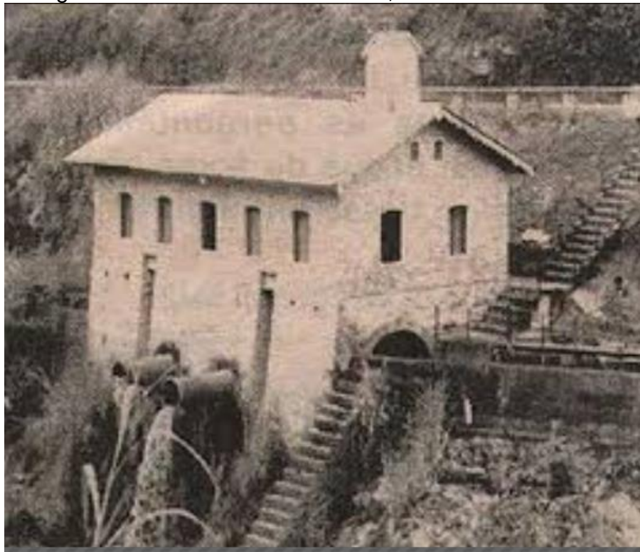
Figura 3: Hidroelétrica de Marmelo, Rio Paraibuna
