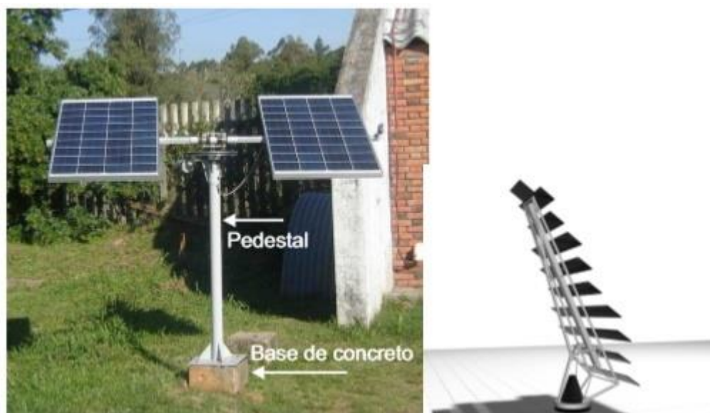
Figura 17 - Rastreador solar com estrutura tipo pedestal (Seguidor vertical ou de Azimute)
