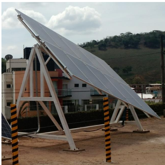
Figura 28 - Estrutura do Rastreador Solar
