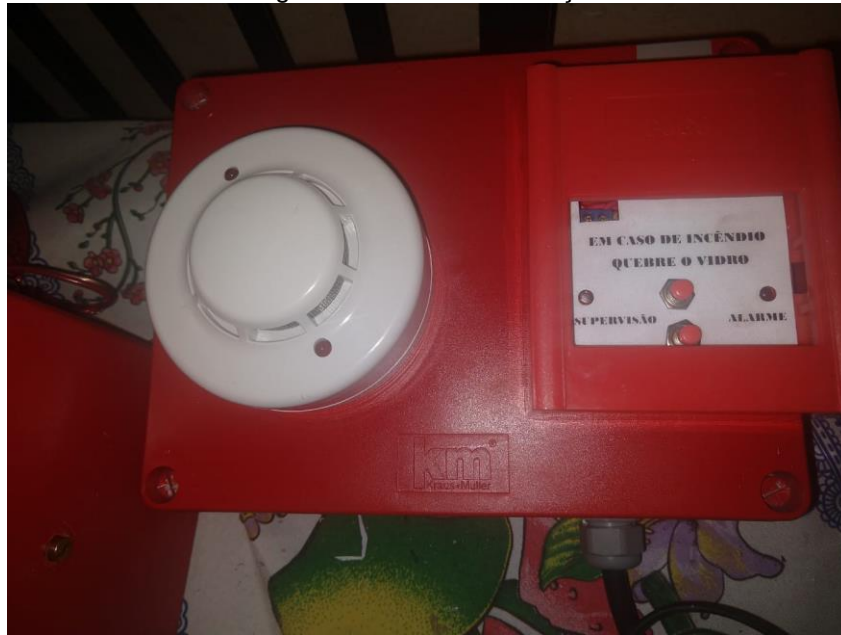
Figura 3: Central de detecção
