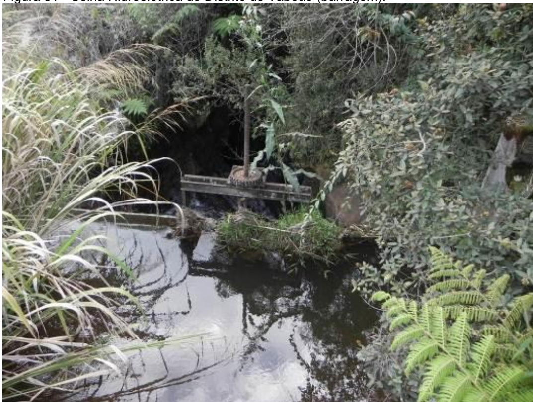
Figura 31 - Usina Hidroelétrica do Distrito de Taboão (barragem).
