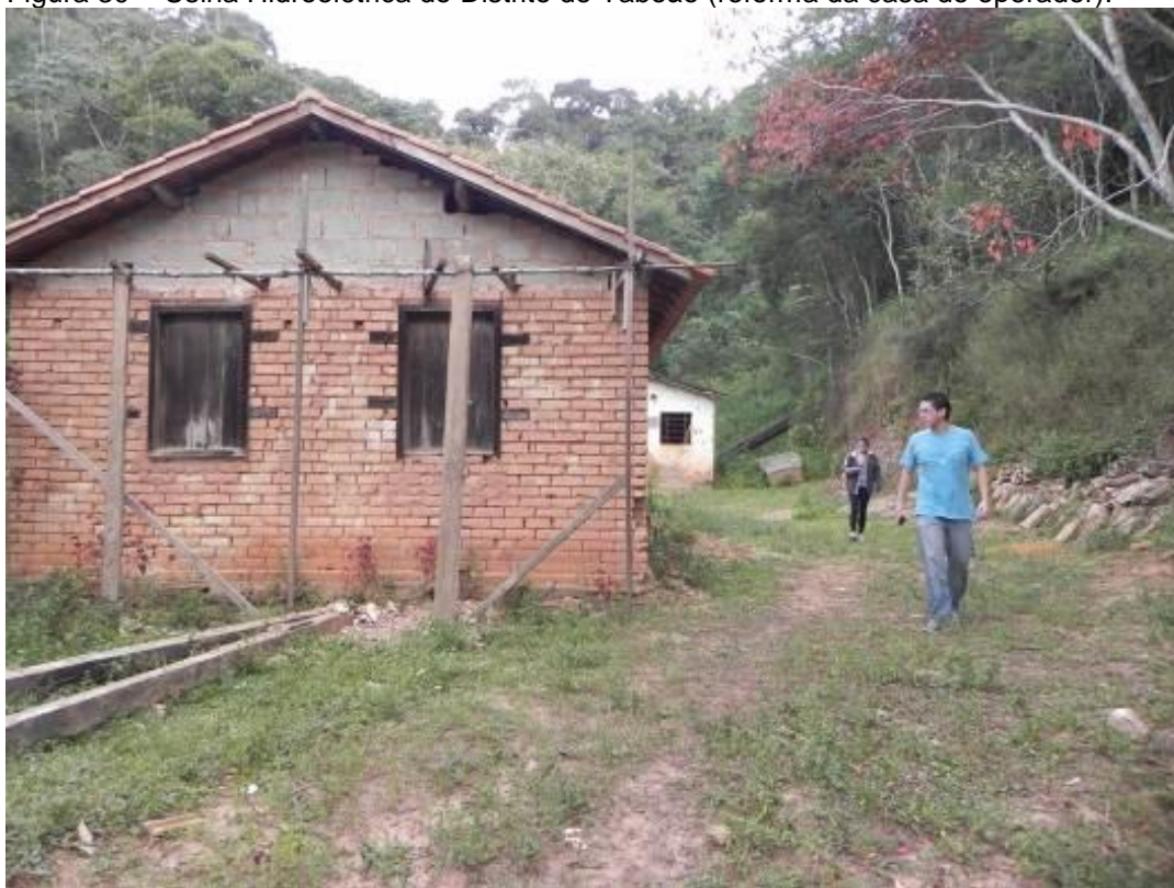
Figura 30 - Usina Hidroelétrica do Distrito de Taboão (reforma da casa do operador).
