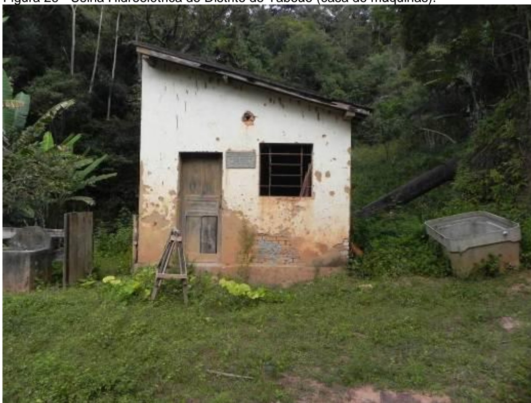
Figura 26 - Usina Hidroelétrica do Distrito de Taboão (casa de máquinas).
