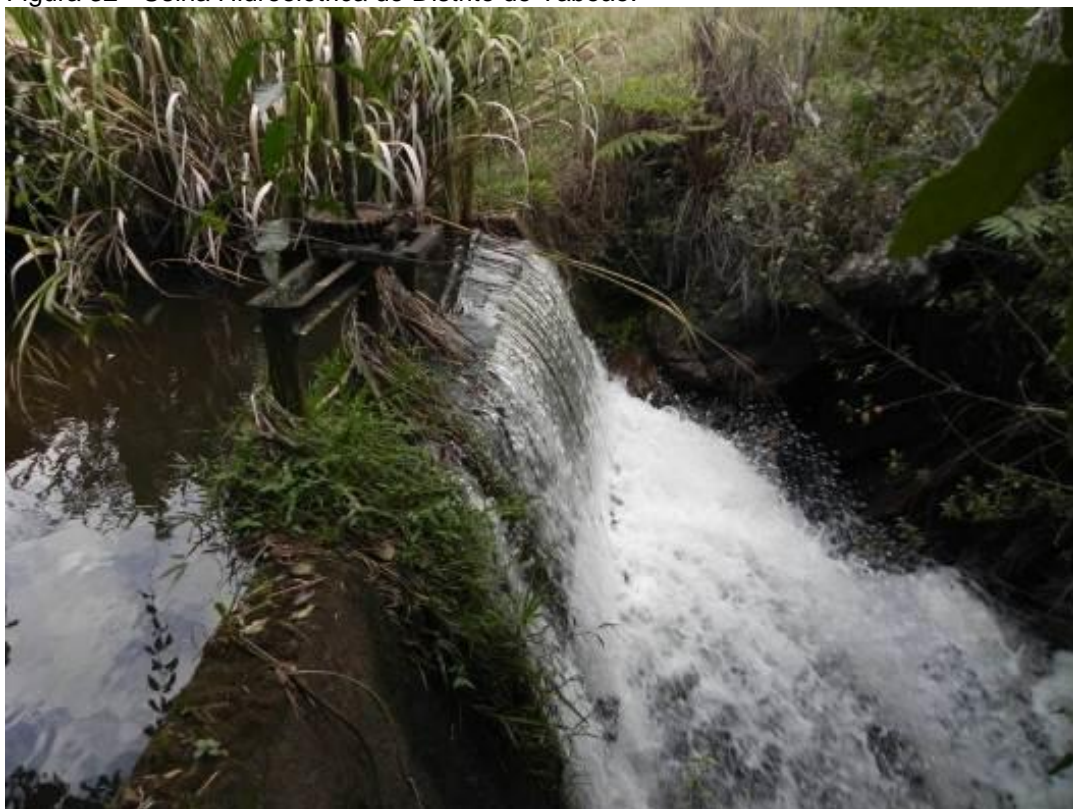
Figura 32 - Usina Hidroelétrica do Distrito de Taboão.
