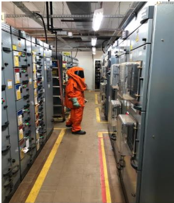
Figura 26 - EPI contra arco elétrico classe quatro
