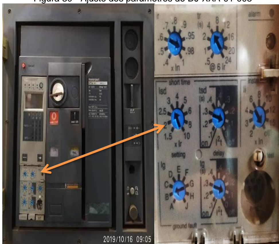
Figura 30 - Ajuste dos parâmetros do DJ-XXA-01-003
