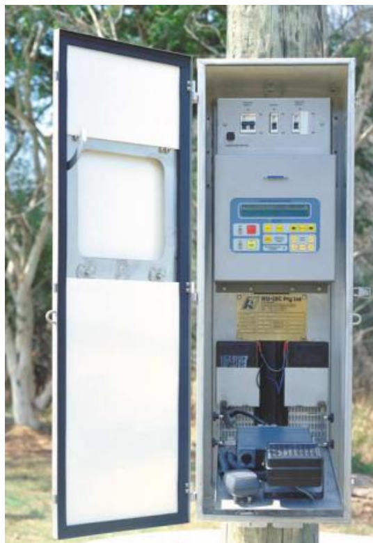
Figura 11 - Controle Microprocessado de um Religador Trifásico
