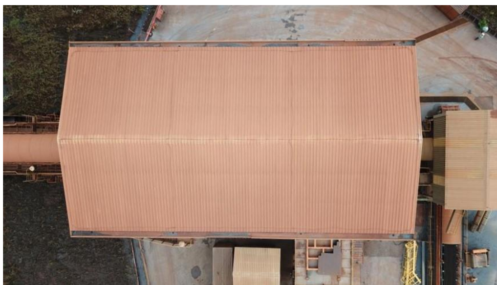
Figura 15 – vista aérea completa do mash de captação
