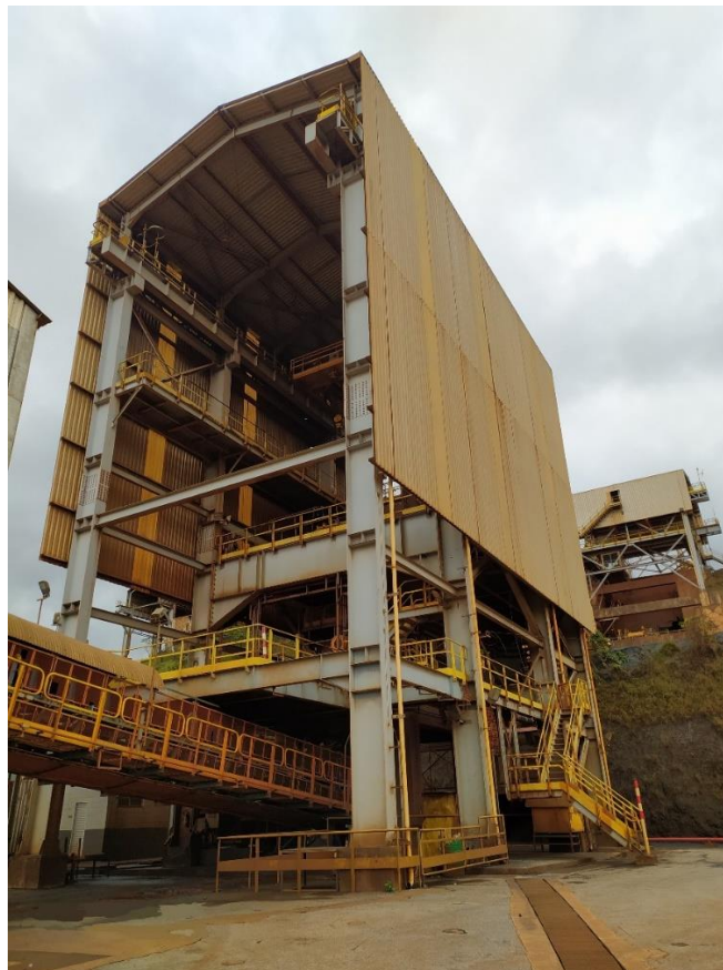
Figura 8 – Prédio de britagem
