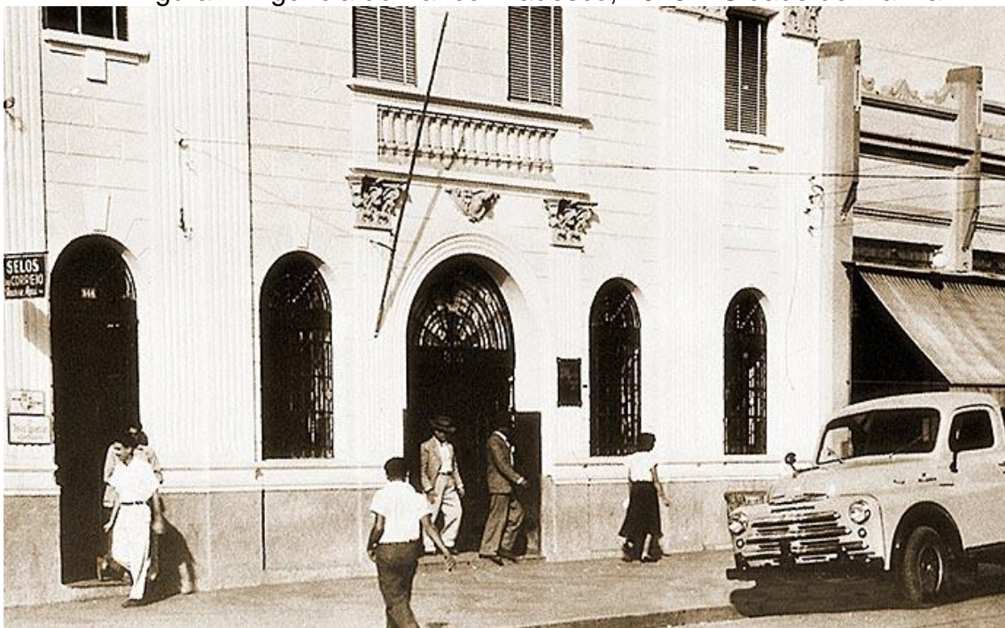
Figura 2: Agência do Banco Bradesco, 1943 – Cidade de Marília
