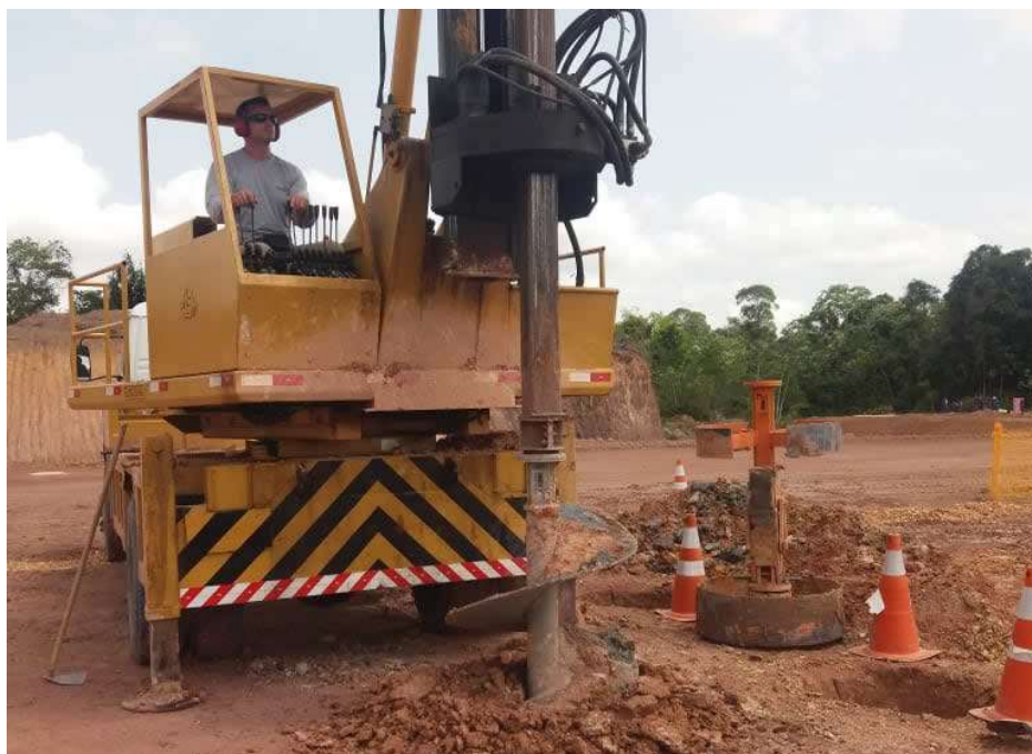
Figura 12 – Início da escavação do fuste
