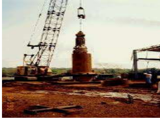
Figura 5 – Tubulão tipo Benotto
