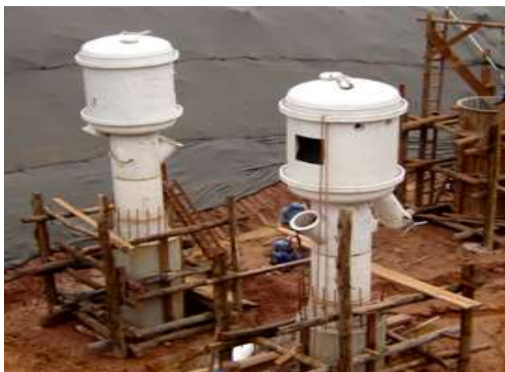
Figura 4 – Tubulão a ar comprimido
