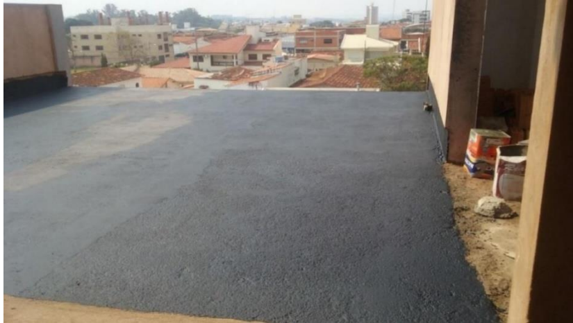
Figura 18 - Imprimação da superfície
