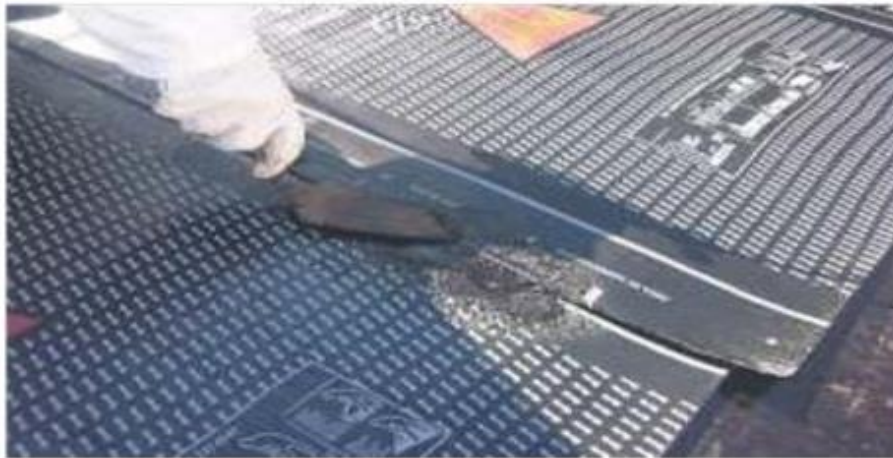
Figura 20 - Procedimento de biselamento
