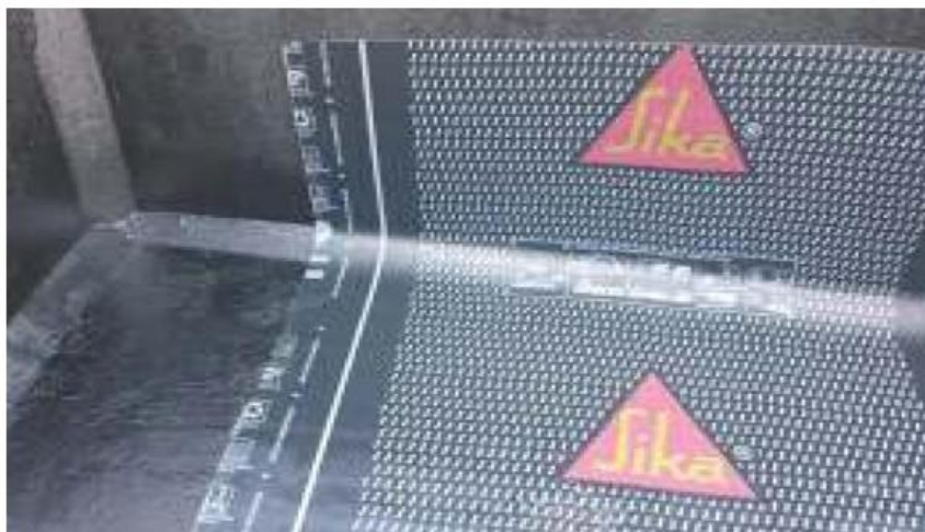
Figura 21 - Rodapé com manta asfáltica
