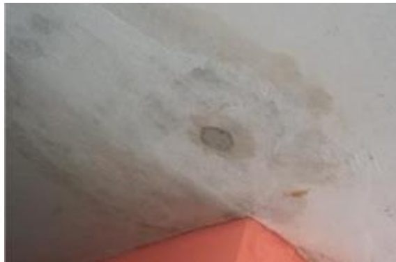
Figura 4 - Mancha d'água no teto
