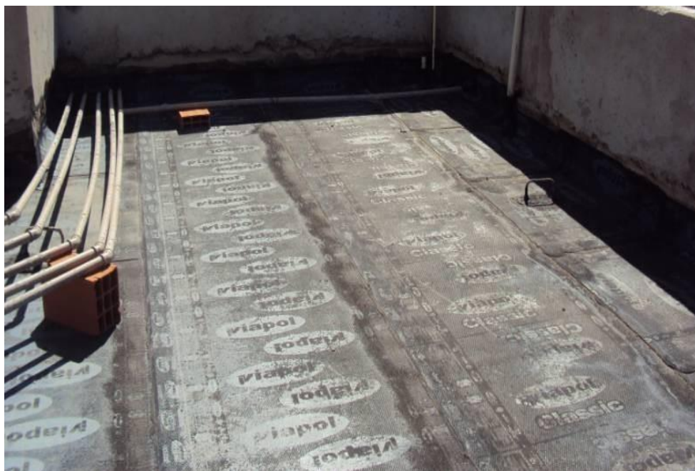
Figura 17 – Manta asfáltica já aplicada
