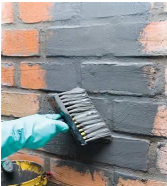
Figura 18 – Aplicação de cristalizante na forma de pintura
