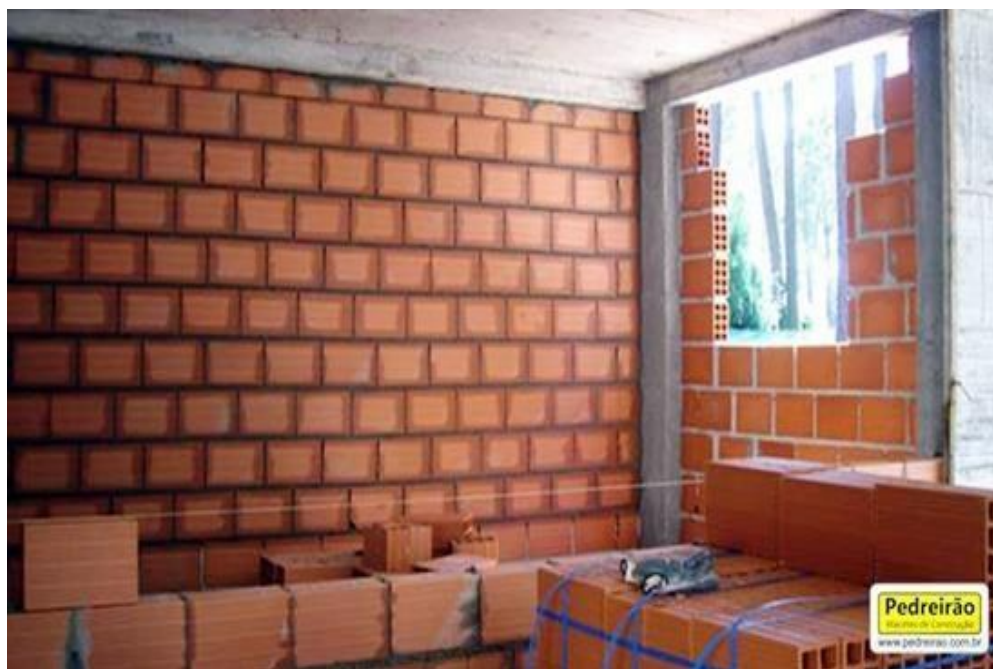
Figura 5 – Umidade de Construção
