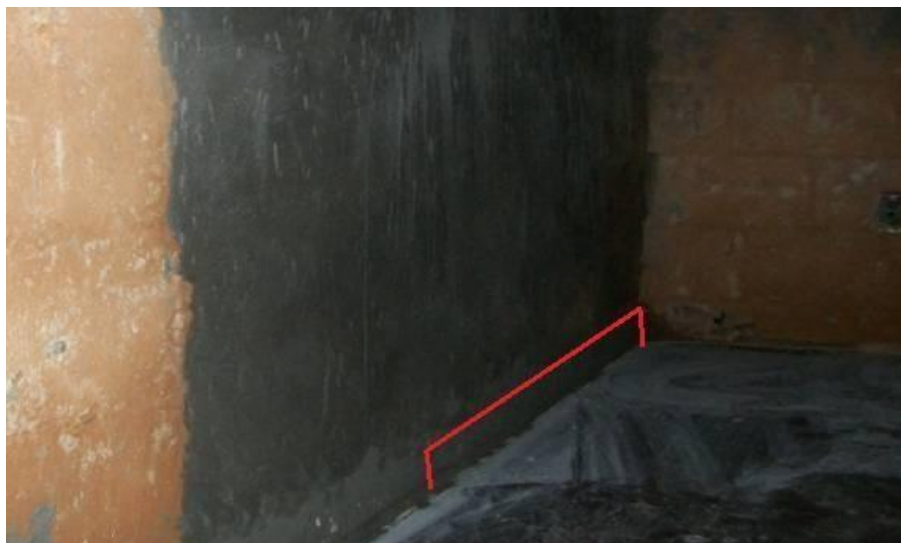
Figura 26 – Parede sendo impermeabilizada
