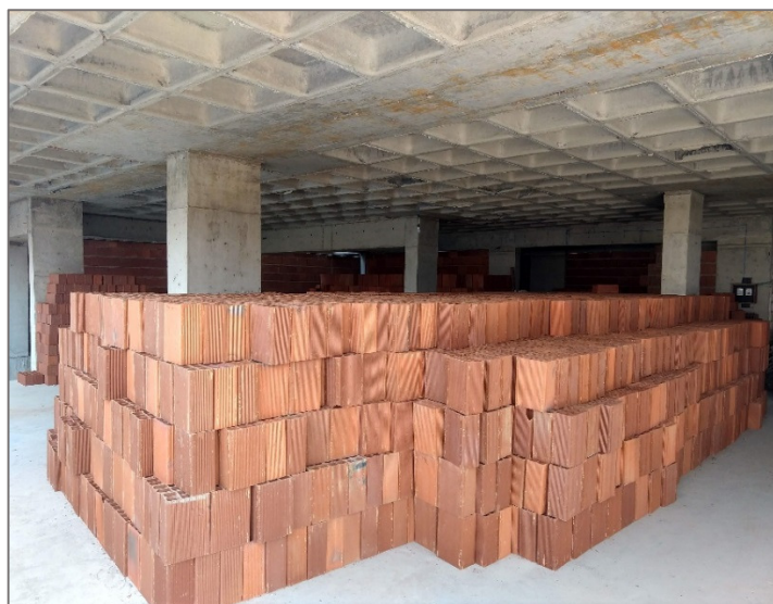
Figura 15: Armazenamento dos tijolos
