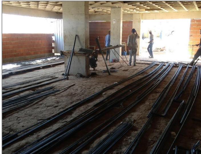
Figura 14: Armazenamento e Conformação dos Vergalhões
