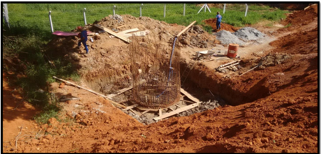
Figura 11: Construção do Sistema de Gradeamento
