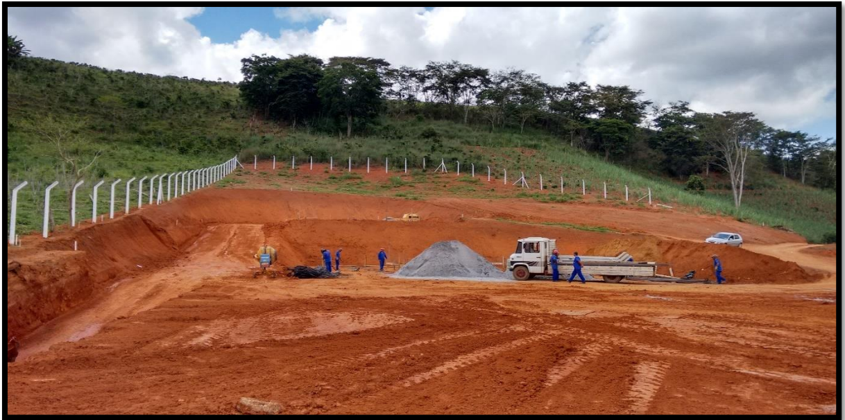
Figura 10: Canteiro de obras da ETE
