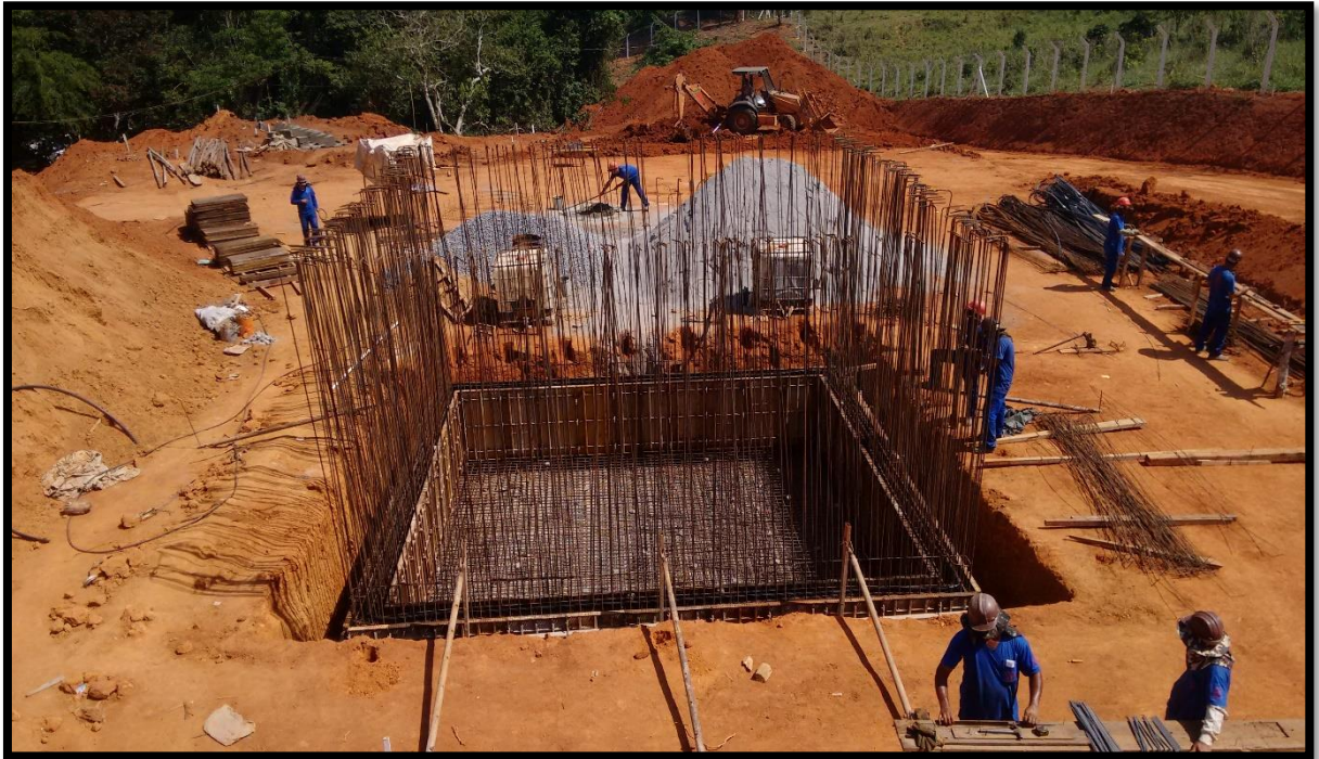
Figura 12: Construção do Tanque de Areação
