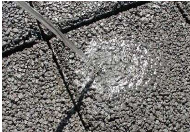
Figura 1: Revestimento Permeável com placas de concreto
