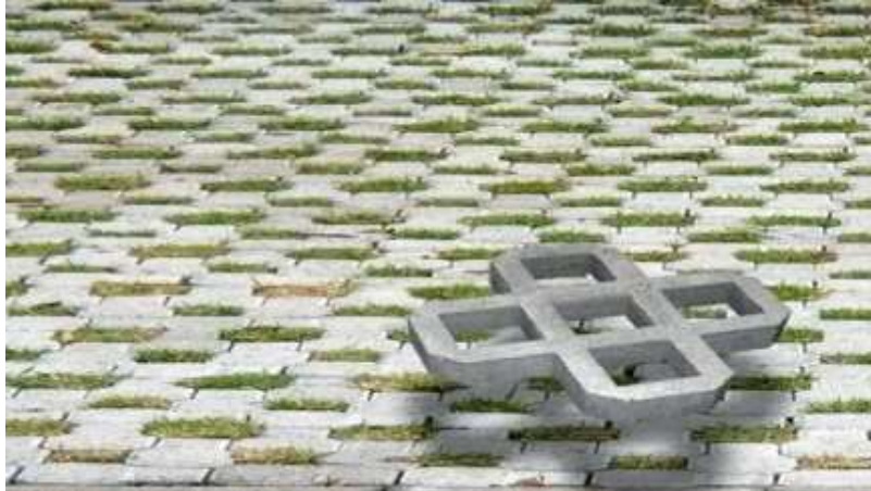
Figura 2: Pavimento com revestimento em concreto vazado
