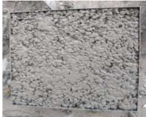
Figura 14: concreto adicionado ao molde quadrado
