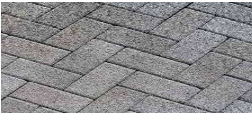
Figura 3: Pavimento de bloco Inter travado poroso
