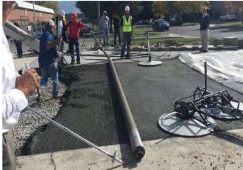
Figura 4: Pavimentação de concreto permeável moldado no local
