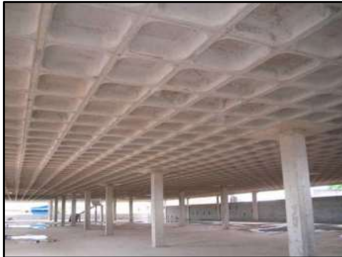
Figura 13 – Laje nervurada
