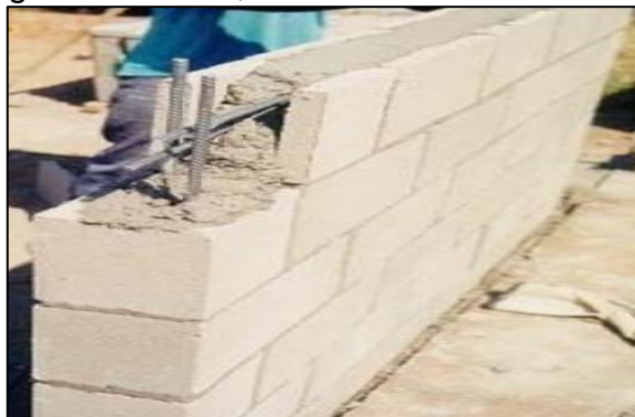
Figura 4: Graute, armadura e bloco canaleta
