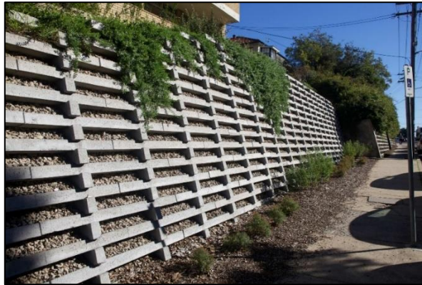
Figura 2– Muro de arrimo “Crib Wall”
