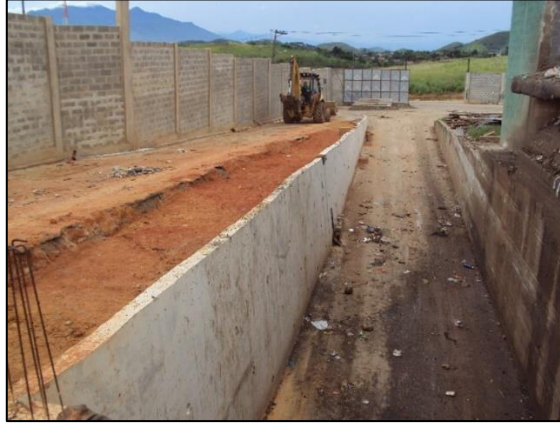
Figura 3– Muro de flexão em concreto armado
