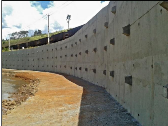
Figura 11– Muro de Cortina Atirantadas
