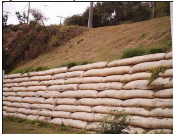
Figura 5– Contenção de saco solo-cimento
