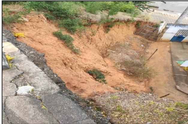
Figura 30– Vista lateral superior do talude estudado
