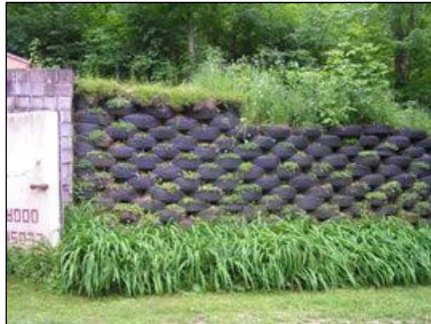
Figura 6– Muro de pneus
