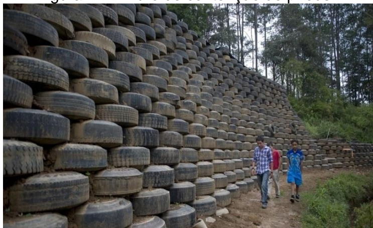
Figura 17 – Muro de contenção de pneus.
