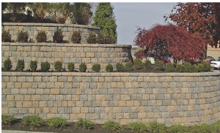
Figura 12 – Muro de pedra com argamassa.
