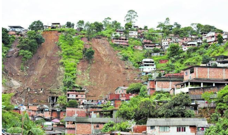
Figura 8 – Movimentos de massa em encosta com construções irregulares.
