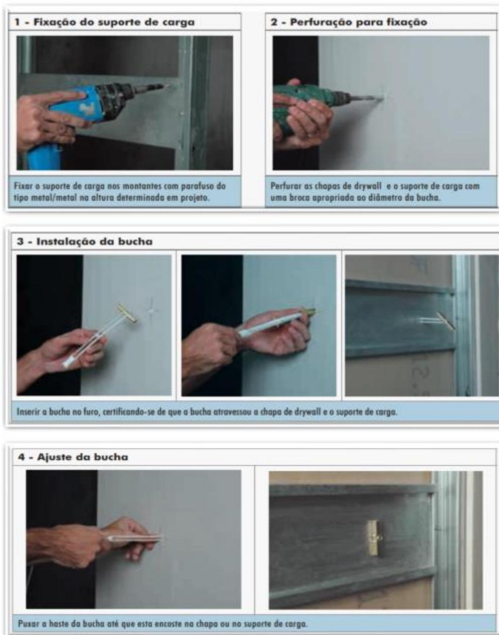
Fonte: Adaptado manual Sistemas *Drywall* Knauf– Manual de Instalação - Knauf *Drywall*, 2019.
