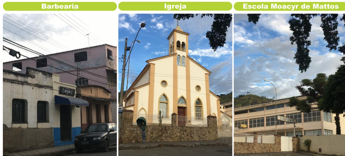
Figura 16: Compilado de fotos de usos do bairro Vale do Sol.
