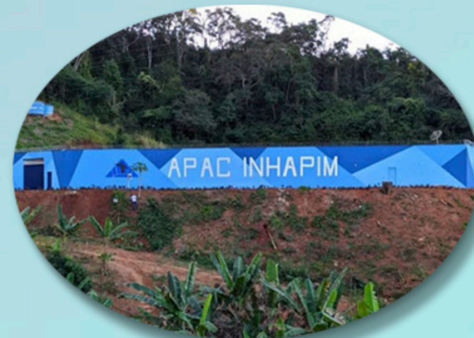
FACHADA APAC INHAPIM Fonte: do autor 2020
