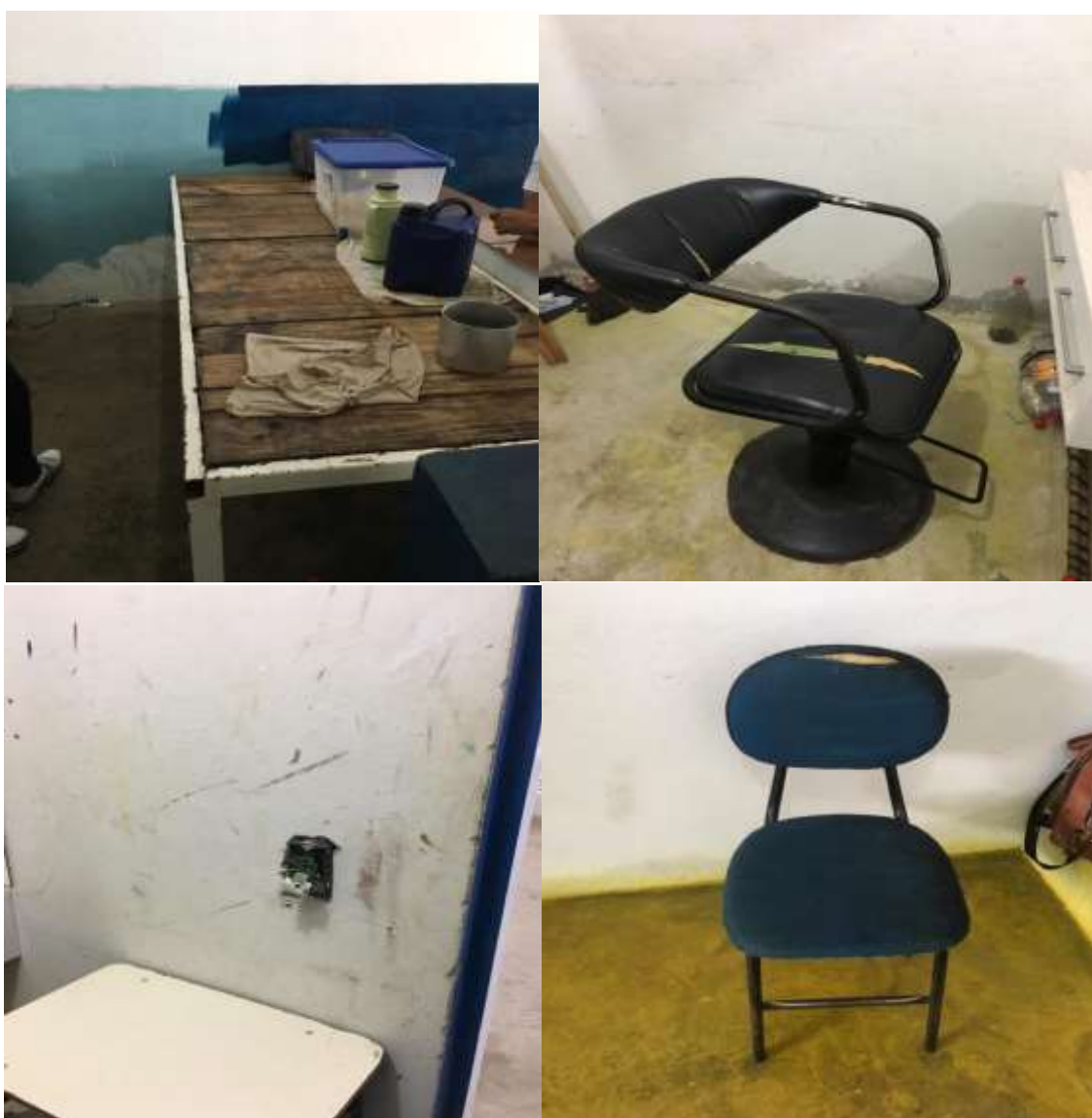
Figura 49: Fotos dos espaços com necessidade de melhoria
