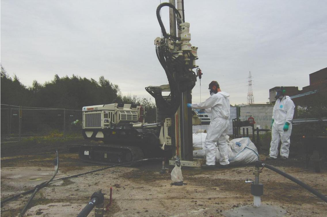
**Figura 5** – Sistema de Extração Multifásica – Fonte: Tecnohidro
