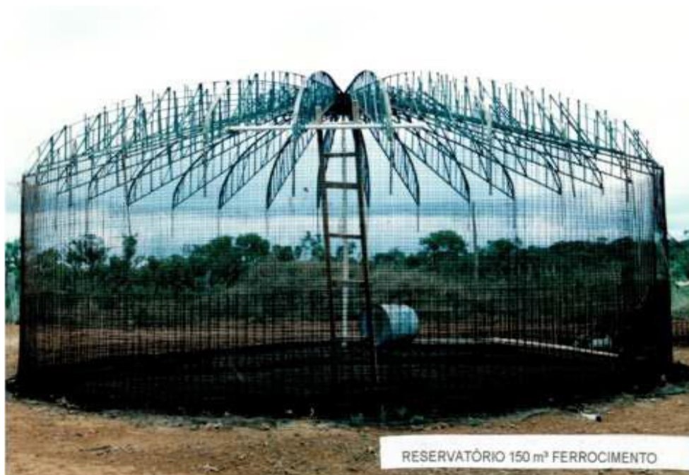
Figura 2: Reservatório em ferrocimento fechado.
