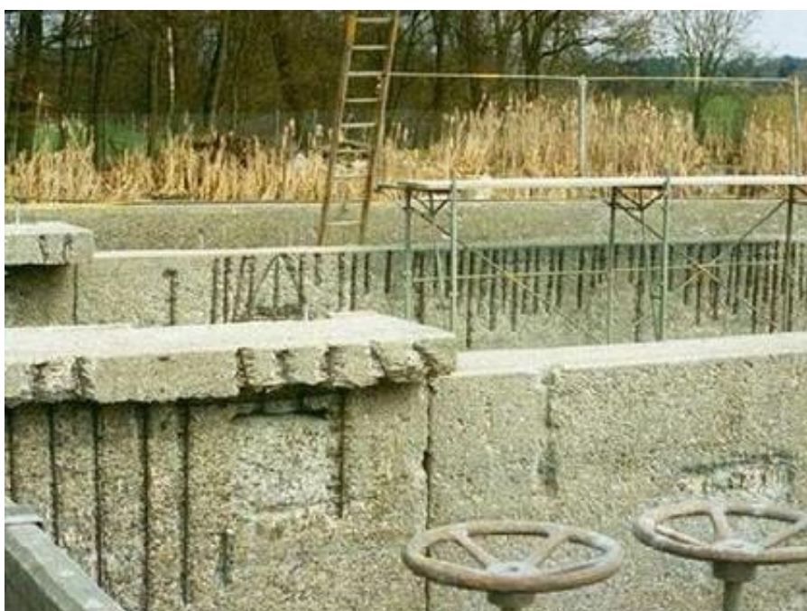
Figura 3: Ataque de gás sulfúrico biogênico
