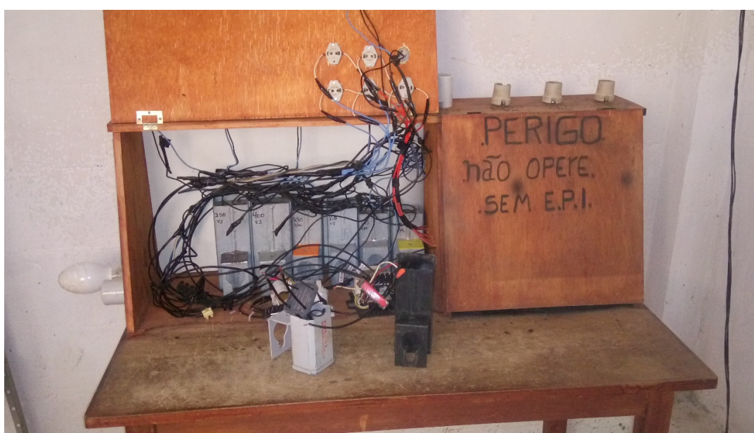
Figura 10: Bancada para testes de reatores da empresa Construrede Eletricidade Ltda.
