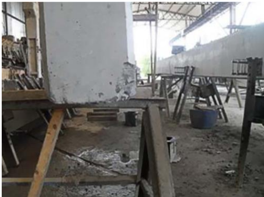
Figura 09: peças pré-moldadas de concreto quebradas no processo industrial. Fonte: MILANI, 2012.
