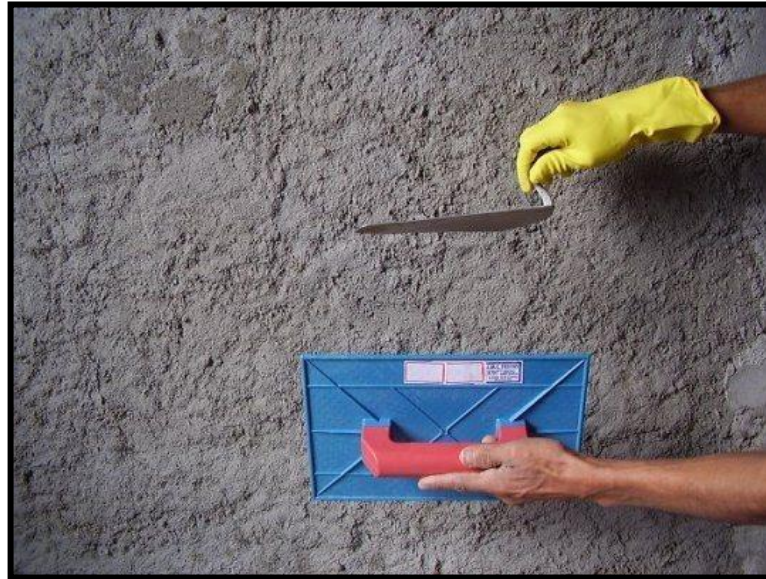
Figura 12- Execução do chapisco
