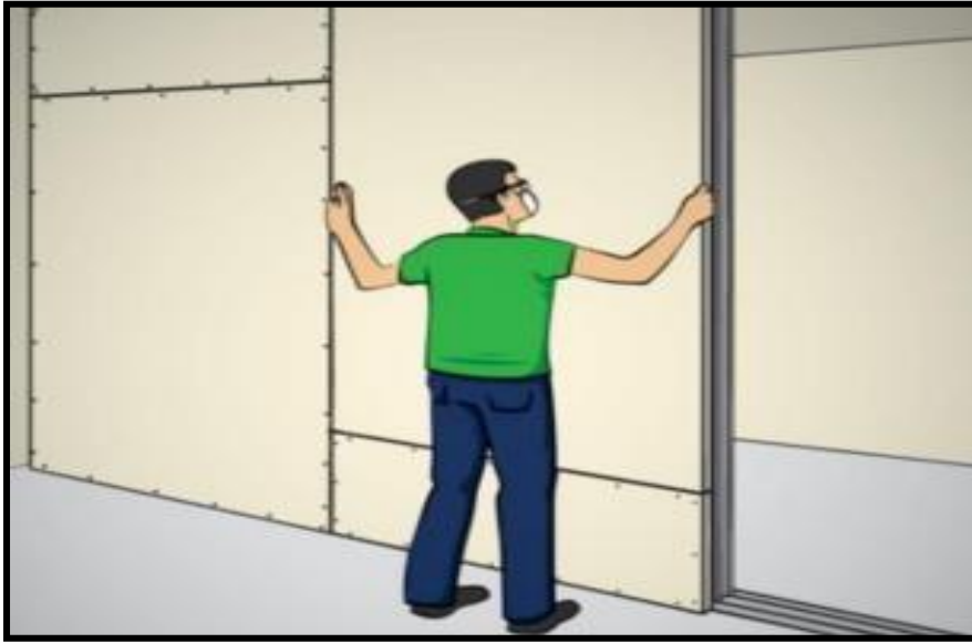
Figura 5 – Instalação das placas de gesso
