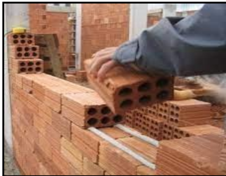
Figura 11- Aplicação da argamassa de assentamento.
