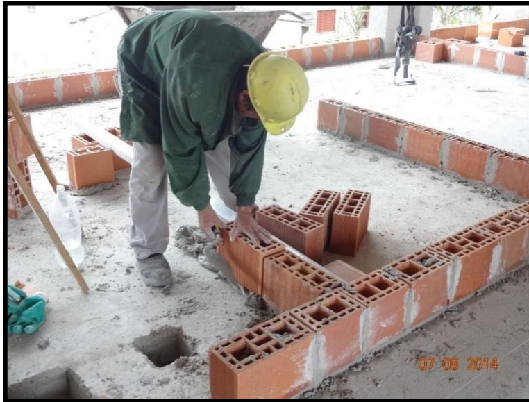
Figura 10- Assentamento da primeira fiada de tijolo cerâmico
