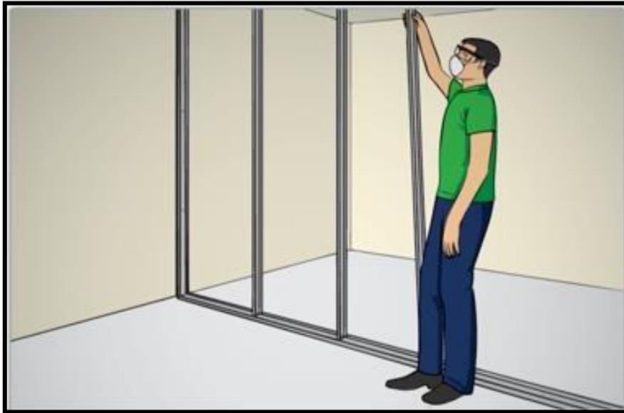
Figura 3 - Instalação dos montantes.
