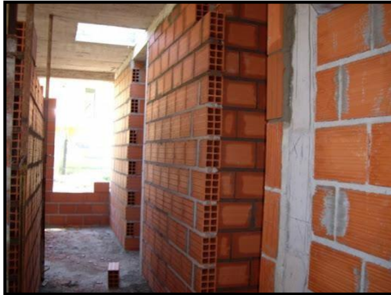
Figura 8 - Paredes em alvenaria de tijolo cerâmico.
