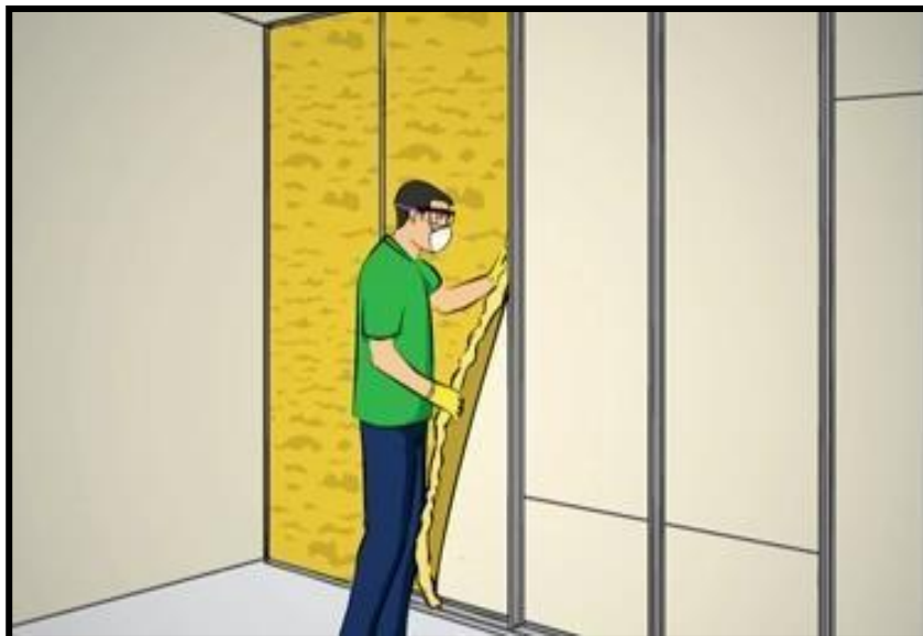
Figura 6- Instalação da lã de vidro.
