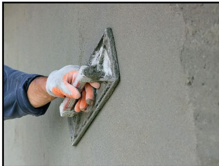
Figura 13- Execução do reboco
