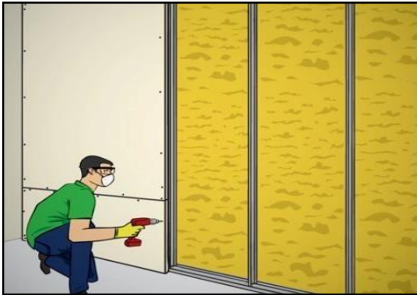
Figura 7- Instalação das placas de gesso para fechamento
