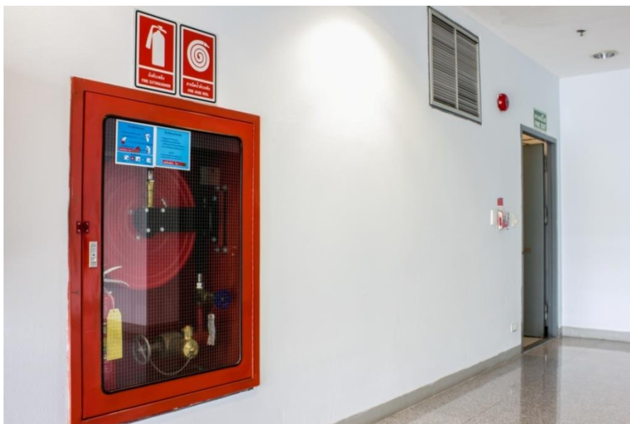
Figura 9. Sistema de Hidrante planejado e embutido.
