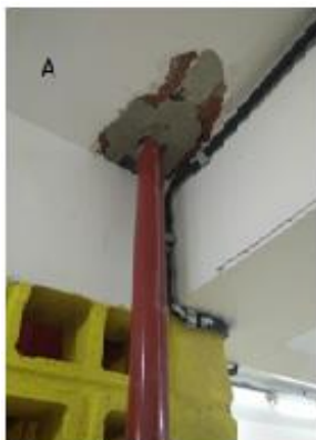
(a) Perfuração da laje.
