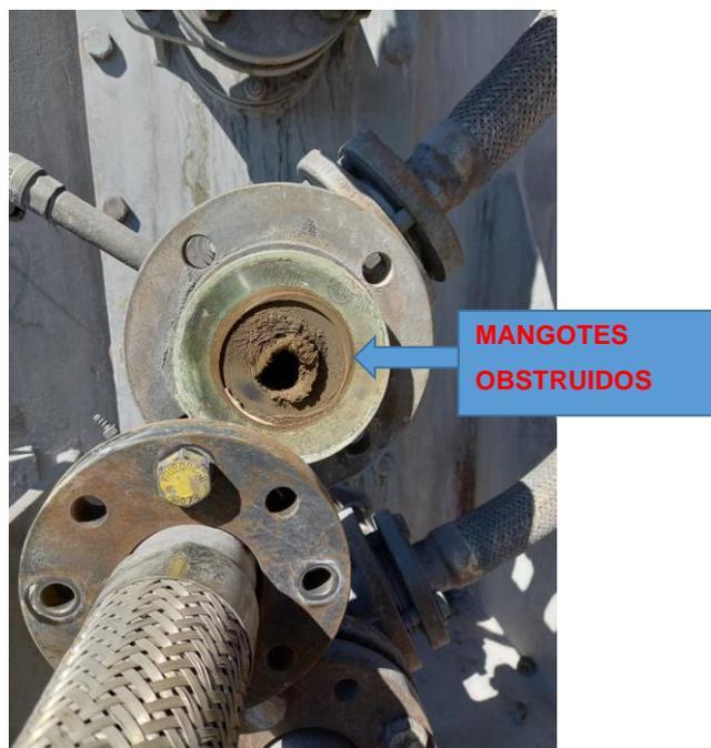
**Figura 10:** Obstrução de mangotes de injeção de LDG
