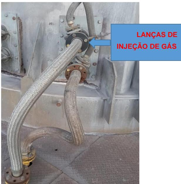
**Figura 09:** Mangotes de injeção de LDG
