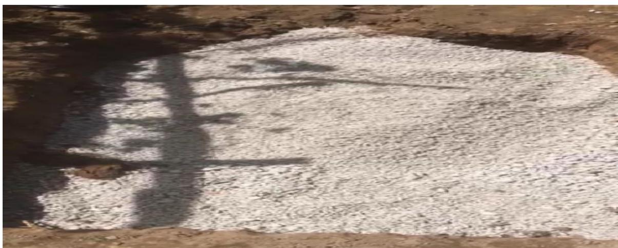
Figura 4- Vala de Infiltração Britada, Autores (2019)
