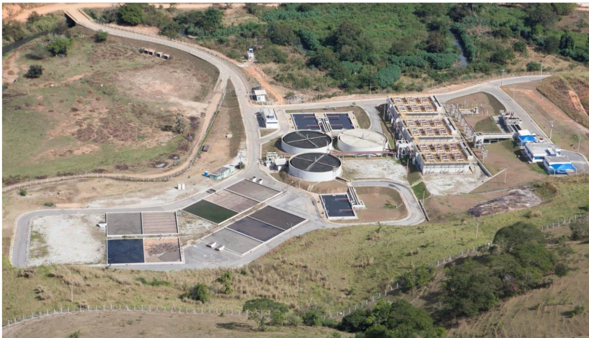
Figura 2 – Fotografia aérea da estação de tratamento de Esgoto de Teófilo Otoni
